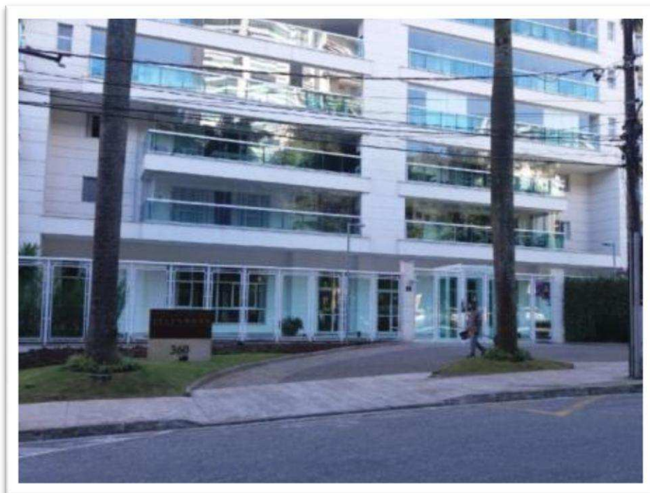
Foto nº 2. Vista frontal do pavimento térreo do Condomínio Residencial Splendore.
