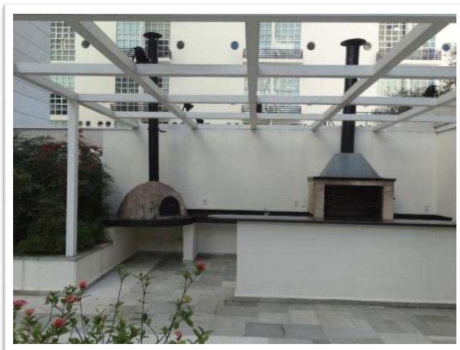
Foto nº 29. Vista da área de churrasqueira do condomínio.
