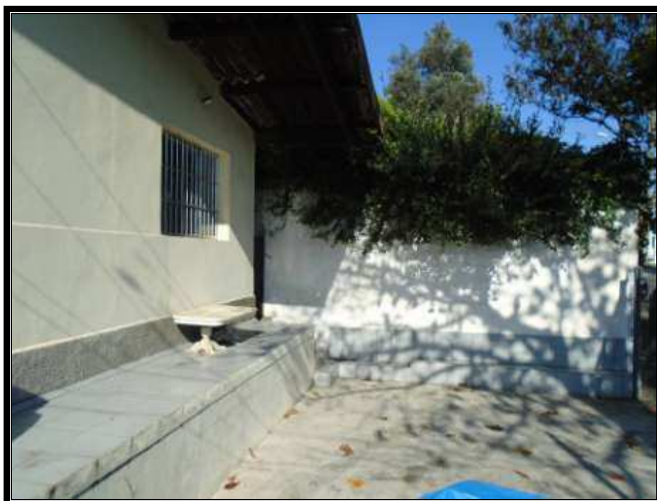
Vista parcial da garagem.
