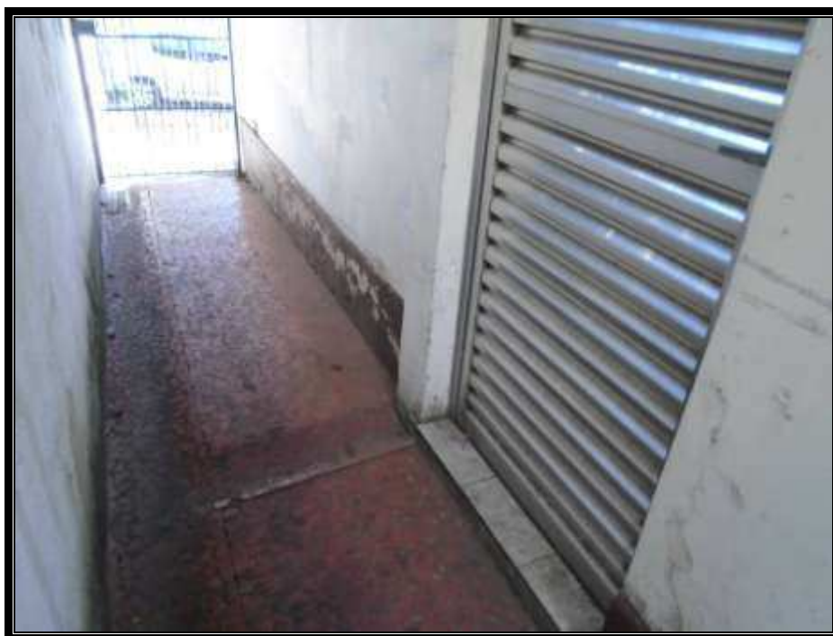
Vista parcial do corredor lateral.
