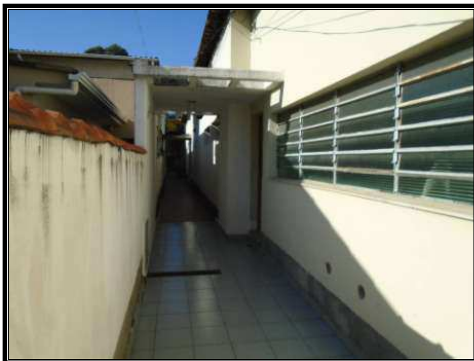
Vista parcial do corredor lateral.
