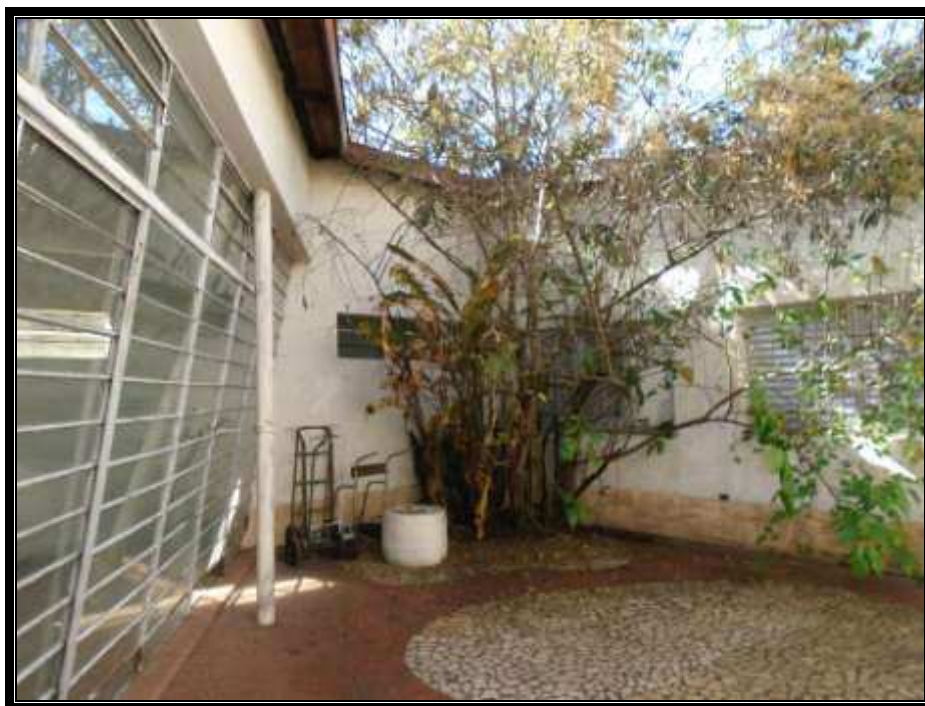
Vista parcial da área dos fundos.
