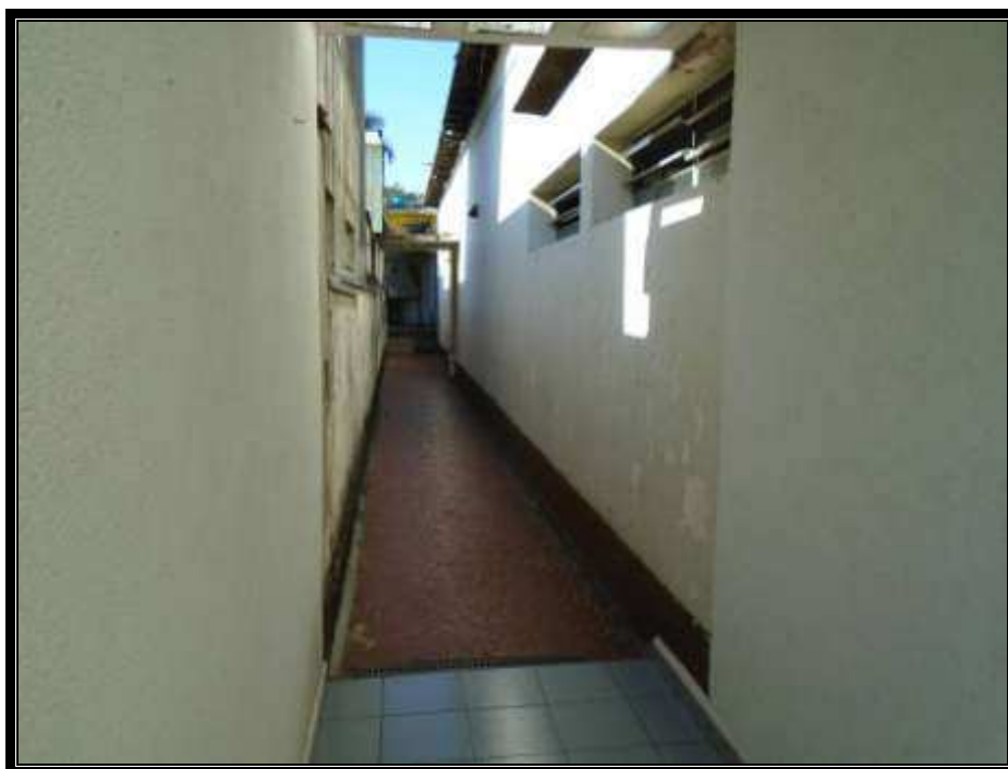
Vista parcial do corredor lateral.
