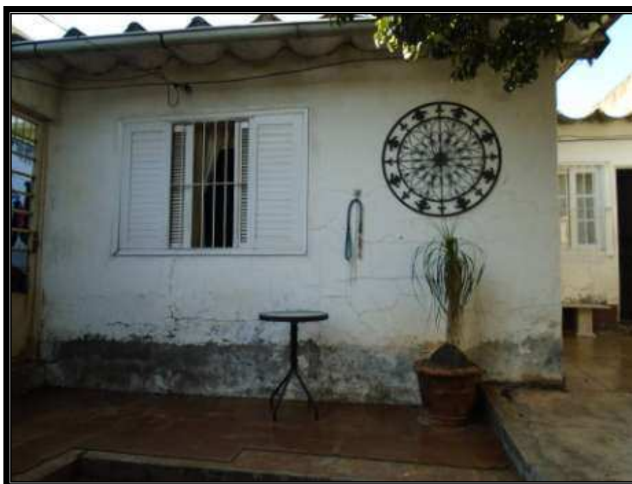
Vista parcial da fachada da edícula.
