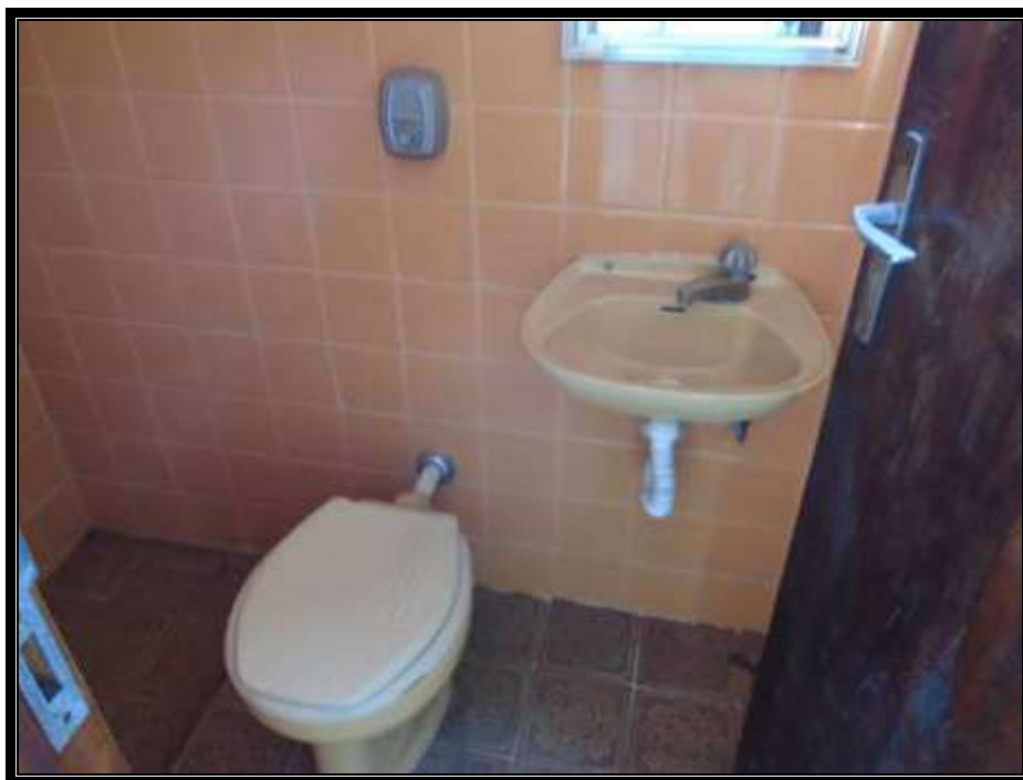
Vista parcial do banheiro.
