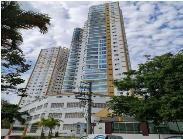
Fachada da Torre I – Edifício Picasso
