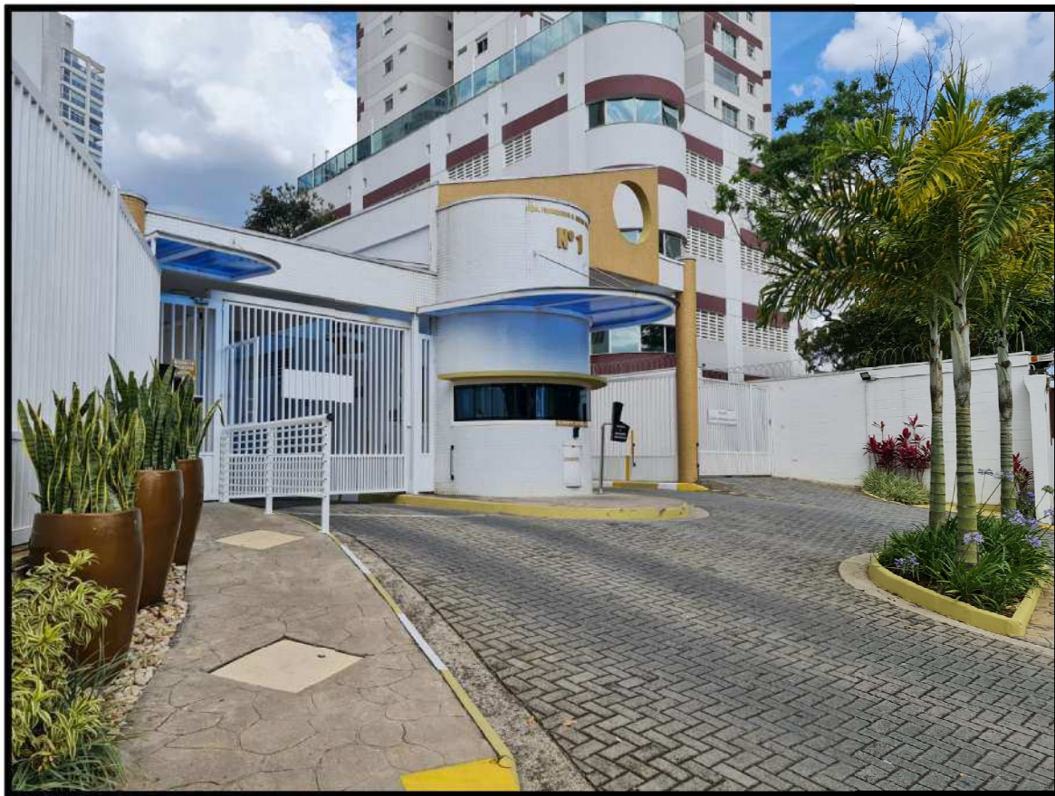
Portaria do condomínio
