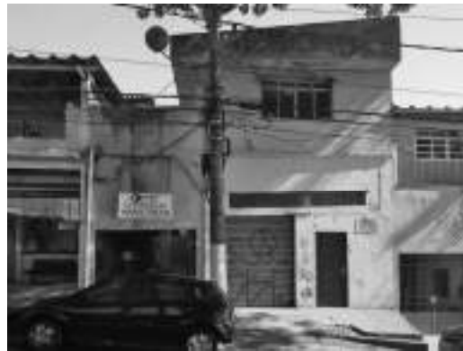
2. RUA CIDADE DE BAGDA, 456
