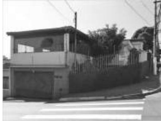
4. RUA CIDADE DE BAGDA, 199
