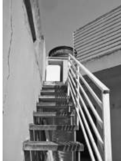
Escada para cobertura
