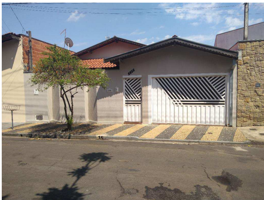
Foto 01:- Fachada do imóvel
