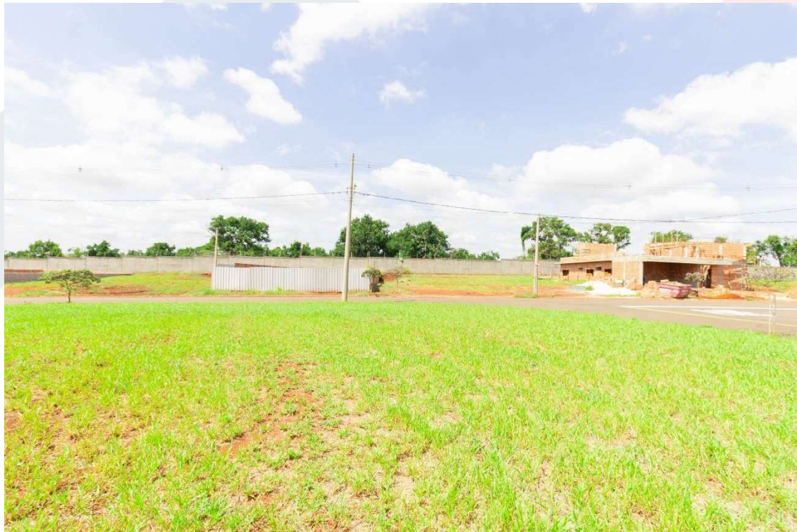
VISTA DO IMÓVEL AVALIANDO.
