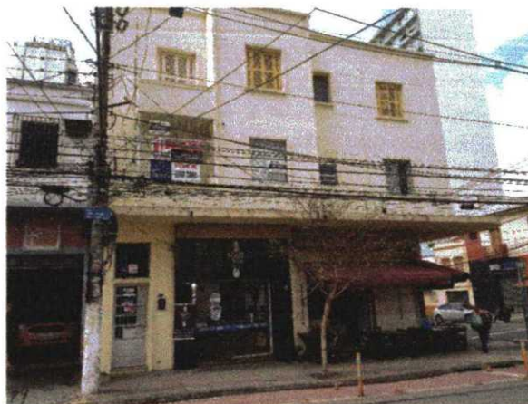
FOTO Nº 01 Vista parcial fachada do Edifício
