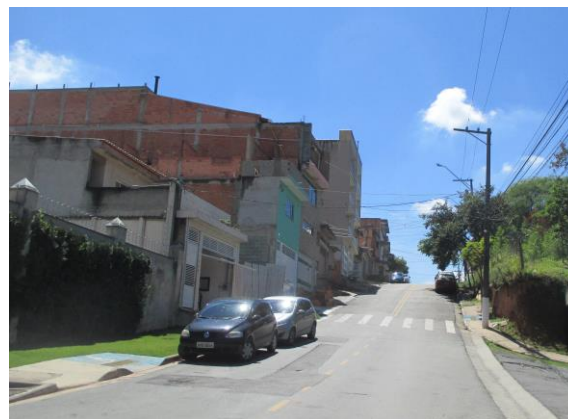
Rua General Carneiro - Local dos Imóveis Avaliando.
