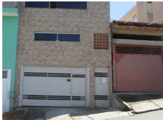
Vista Externa do Imóvel "D" – Lote 13-D.
