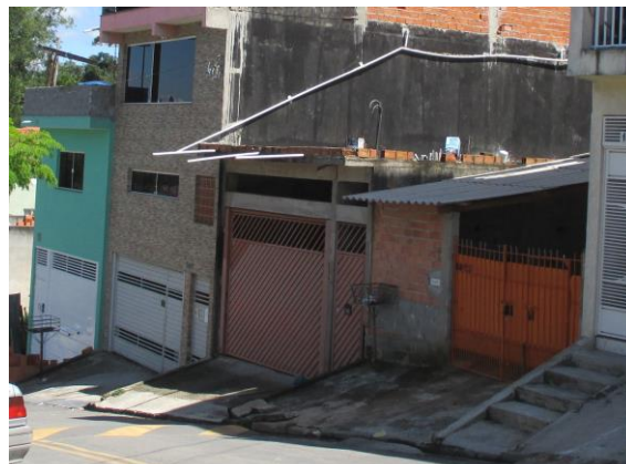
Vista Externa dos Imóvel "E" e "F" – Lotes 13-E e 13-F.
