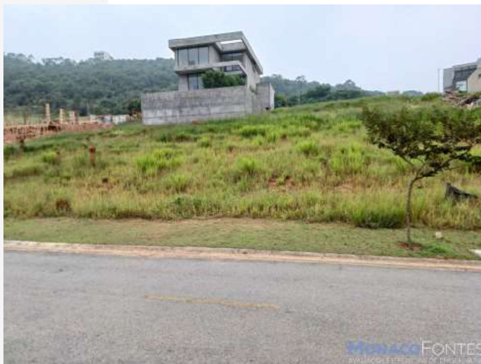
Na imagem acima, tem-se uma tomada da testada do imóvel, onde nota-se a acessibilidade direta do terreno em relação a Rua Monte Everest.
