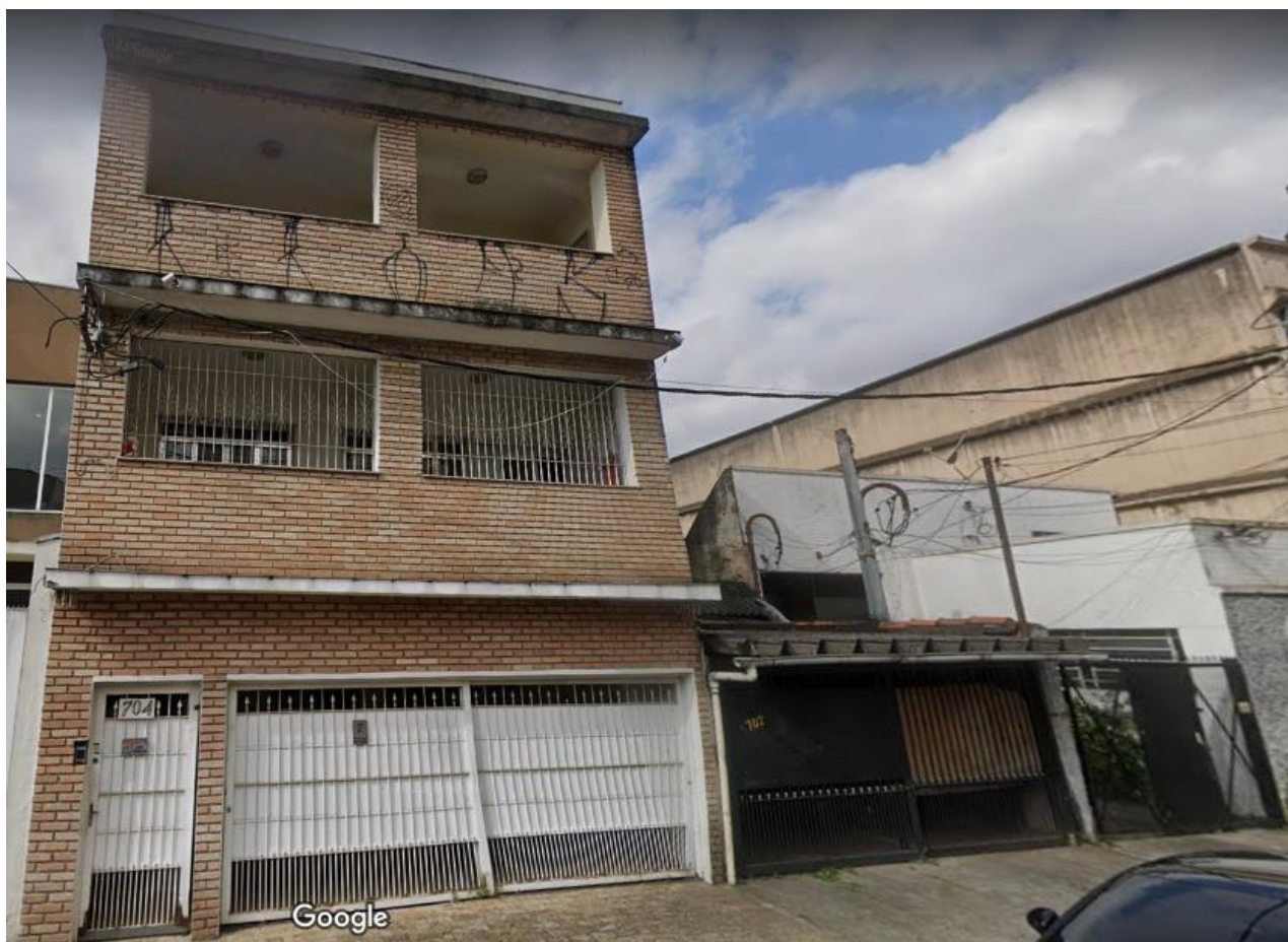
Imagem da Fachada Rua Bernardino Fanganiello,704
