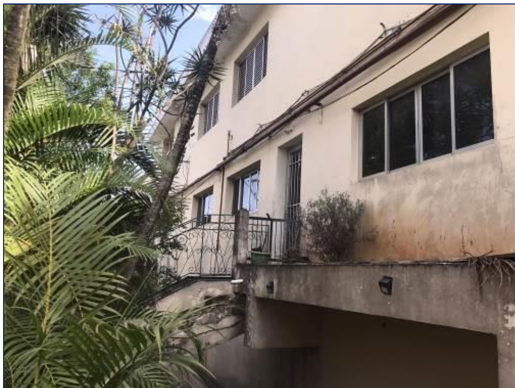
FOTO N° 08: VISTA DO PRÉDIO ADMINISTRATIVO.
