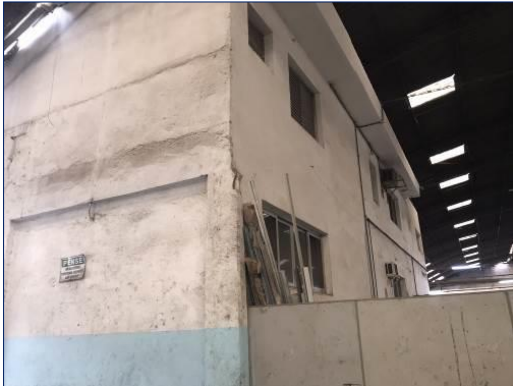
FOTO N° 12: VISTA DO PRÉDIO ADMINISTRATIVO.
