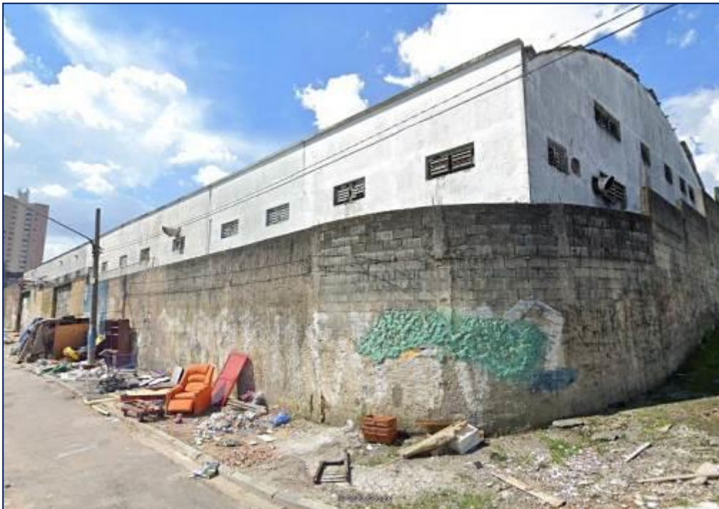
FOTO Nº 13: VISTA DO IMÓVEL COM FRENTE PARA A RUA PEDRO AMÂNCIO E RUA KURT ENGELHART.
