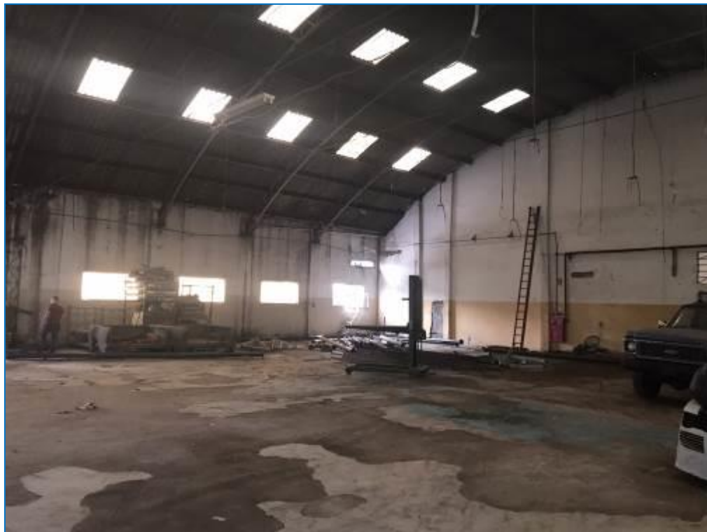
FOTO N° 10: OUTRA VISTA DO GALPÃO.
