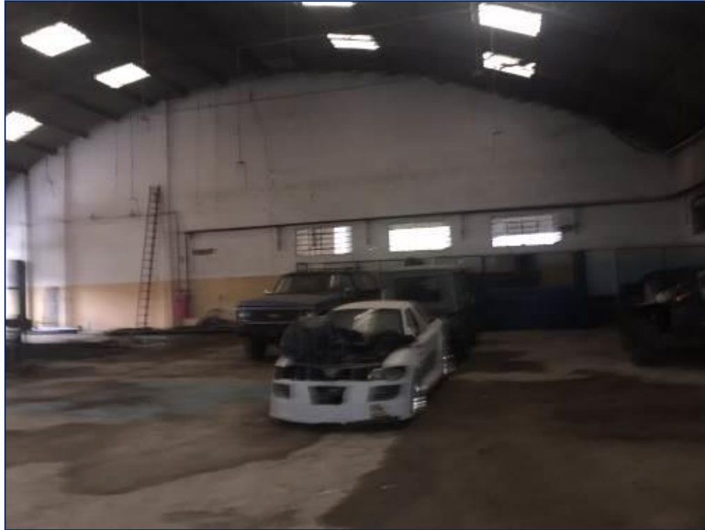
FOTO N° 11: VISTA DO GALPÃO.
