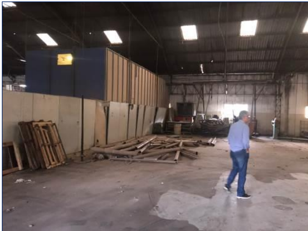
FOTO N° 06: VISTA INTERNA DE UM GALPÃO.
