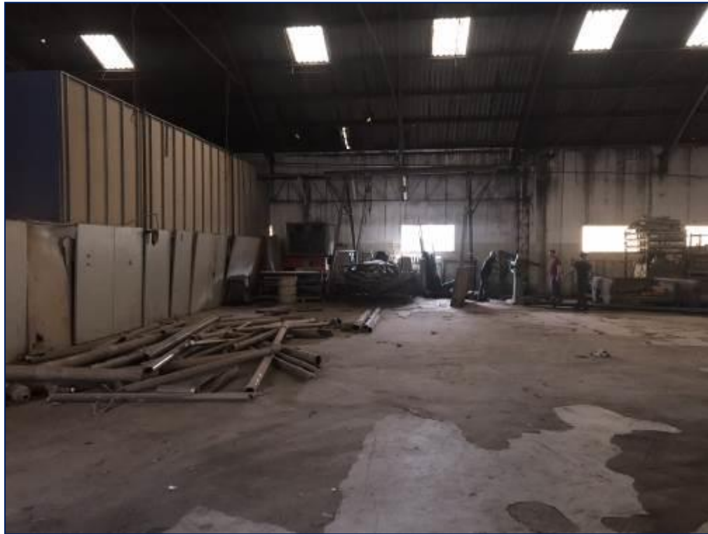
FOTO N° 09: VISTA DO GALPÃO.
