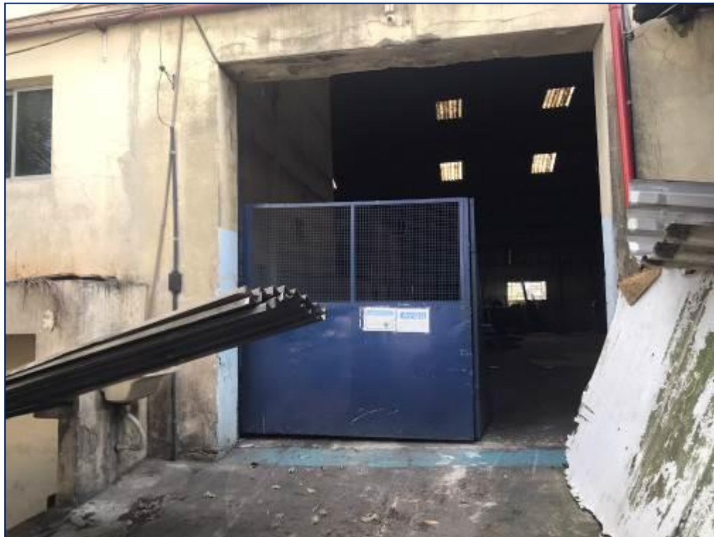
FOTO N° 07: VISTA DO PORTÃO DE ACESSO AO GALPÃO.
