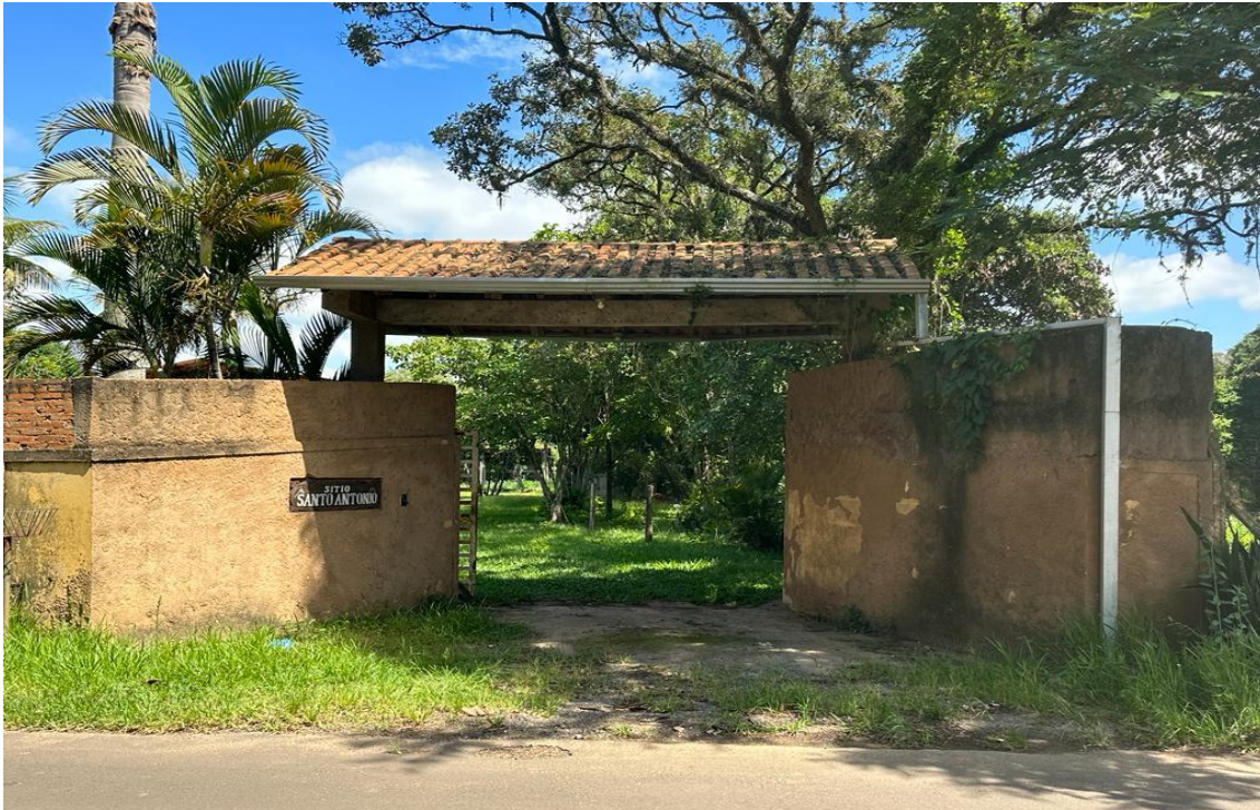
Portão de acesso ao sítio
