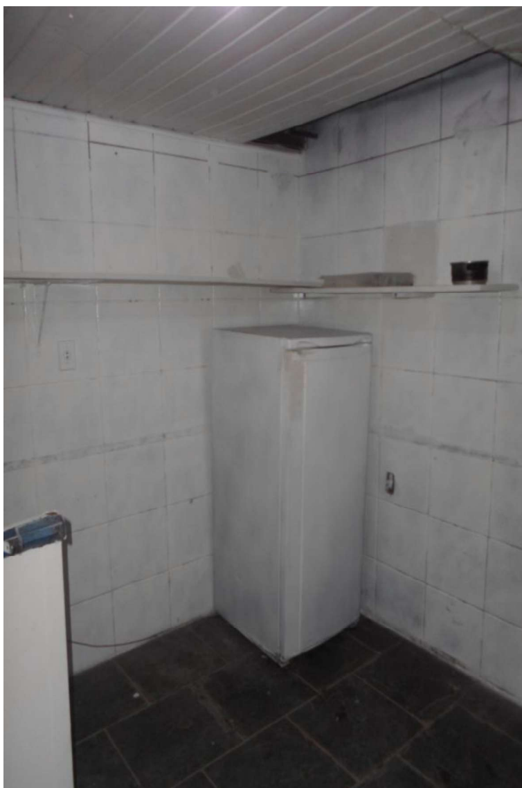
FOTO 9 – Anexo fotográfico destinado a mostrar a cozinha existente no barracão localizado na frente do lado esquerdo do imóvel, podendo-se observar o piso de ardósia, o forro de PVC e o revestimento de azulejo existente na mesma.
