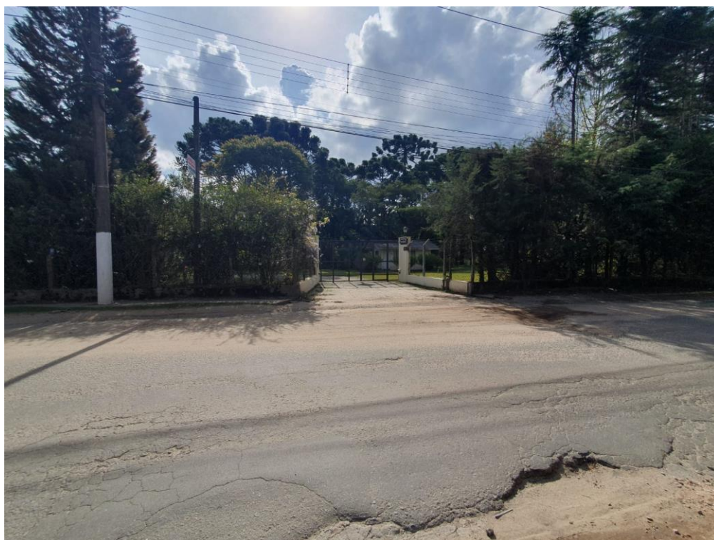
Foto 04 – Outra vista geral da fachada
