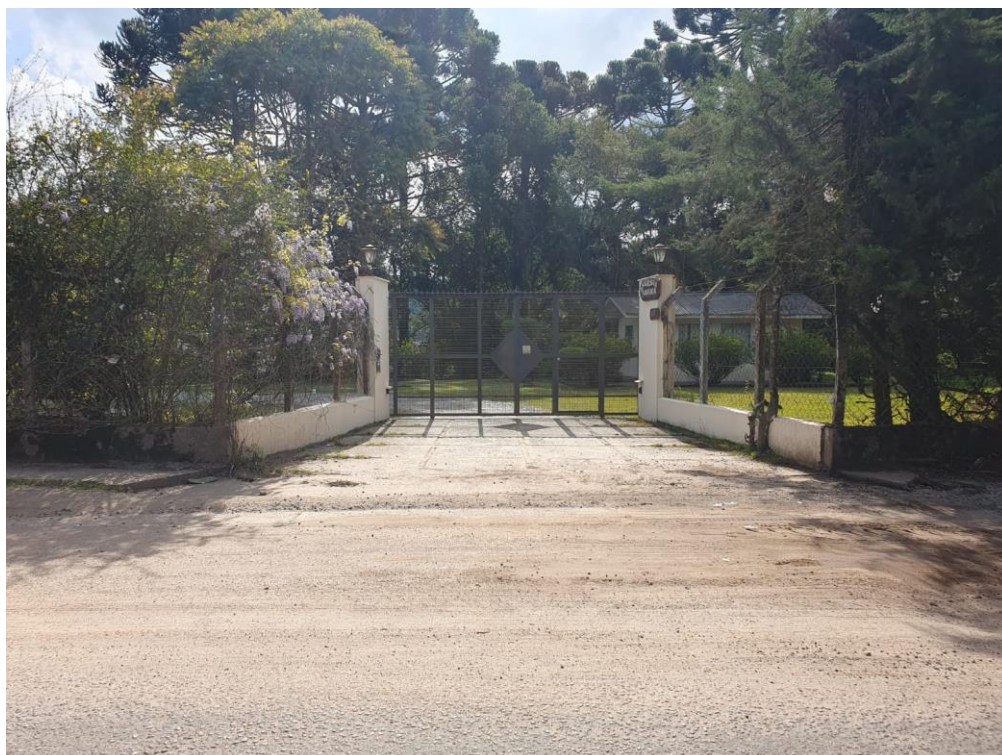
Foto 03 – Vista Geral da fachada
