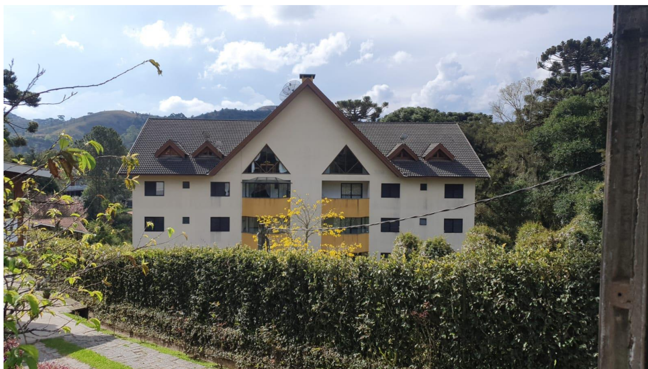
Foto 10 – Vista geral interna do avaliando, fotografia tirada do portão de acesso
