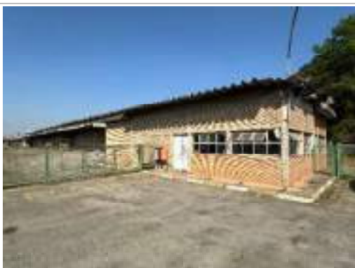
Vista Geral - Portaria
