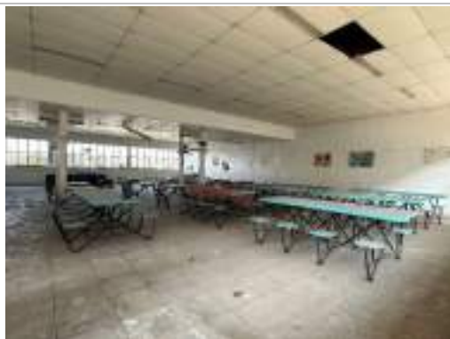
Vista Geral – Administração Refeitório
