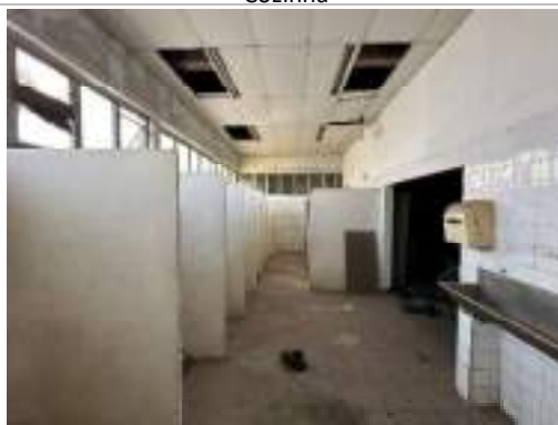
Vista Geral – Administração Sanitário
