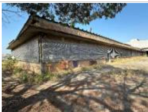
Vista Geral - Administração
