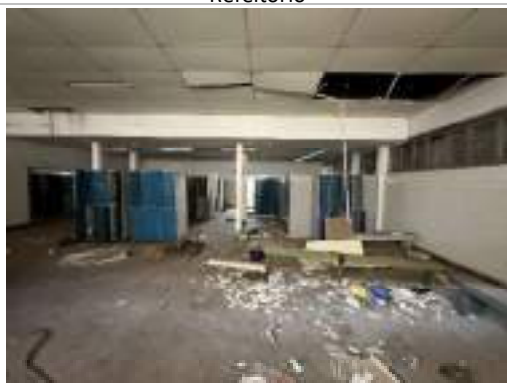
Vista Geral – Administração Vestiário
