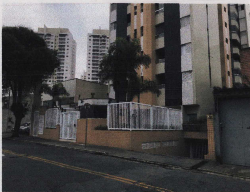
Imagem 2 - Vista do recuo frontal do edifício.
