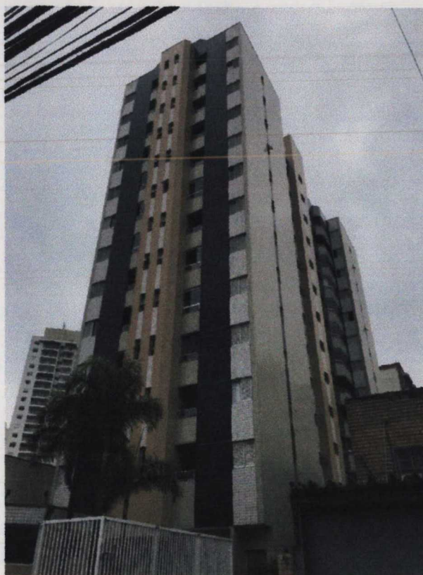
Imagem 1 - Vista da fachada do edifício.
