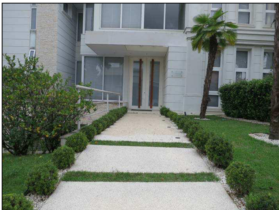
Fotos 06 e 07: Vistas externas para o acesso principal.
