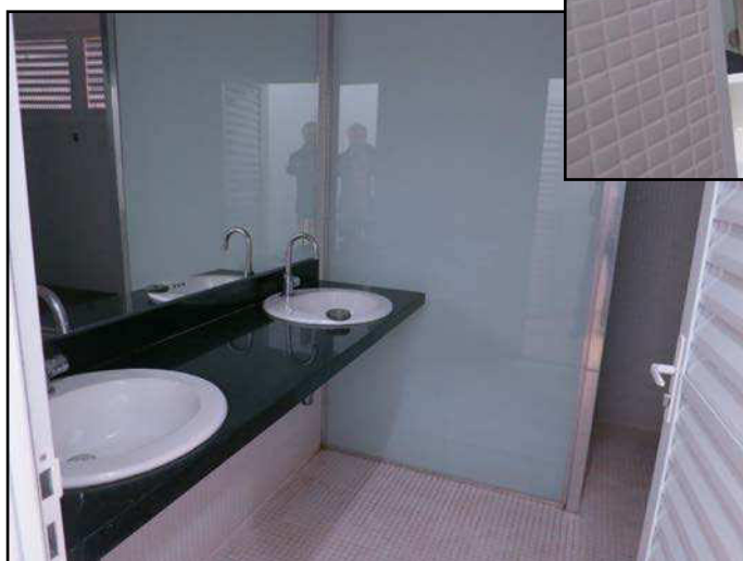
Fotos 10 e 11 e 12: Vistas internas dos vestiários.
