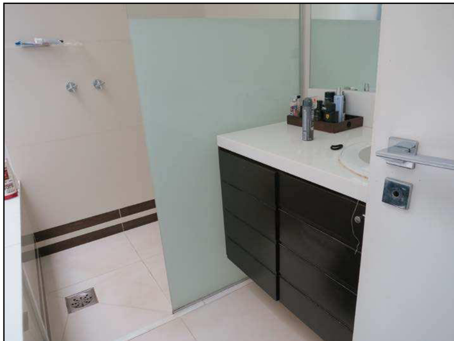
Fotos 62 e 63: Vistas parciais dos banheiros.
