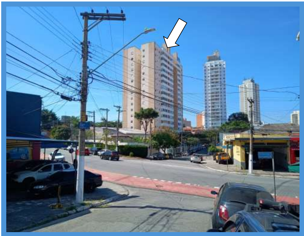
VISTA LONGITUDINAL DA RUA JOSÉ PEREIRA DE CARVALHO, OBSERVANDO – SE O CONDOMINIO EDIFÍCIO COLORE JAGUARÉ.
