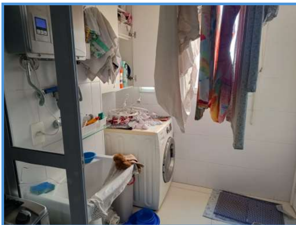
VISTA DA AREA DE SERVIÇO.
