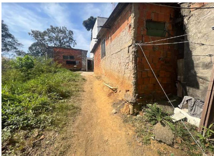
Vista geral do terreno - Destaque para a construção irregular no terreno
