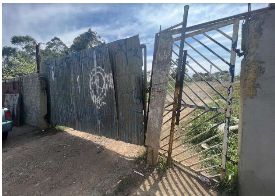
Vista geral do acesso ao terreno
