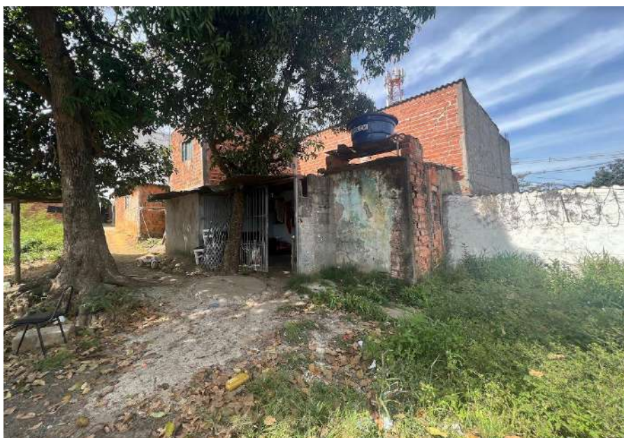
Vista geral do terreno - Destaque para a construção irregular no terreno
