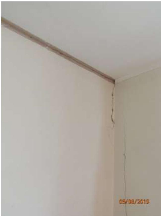
Foto 14 – Trincas e rachaduras
