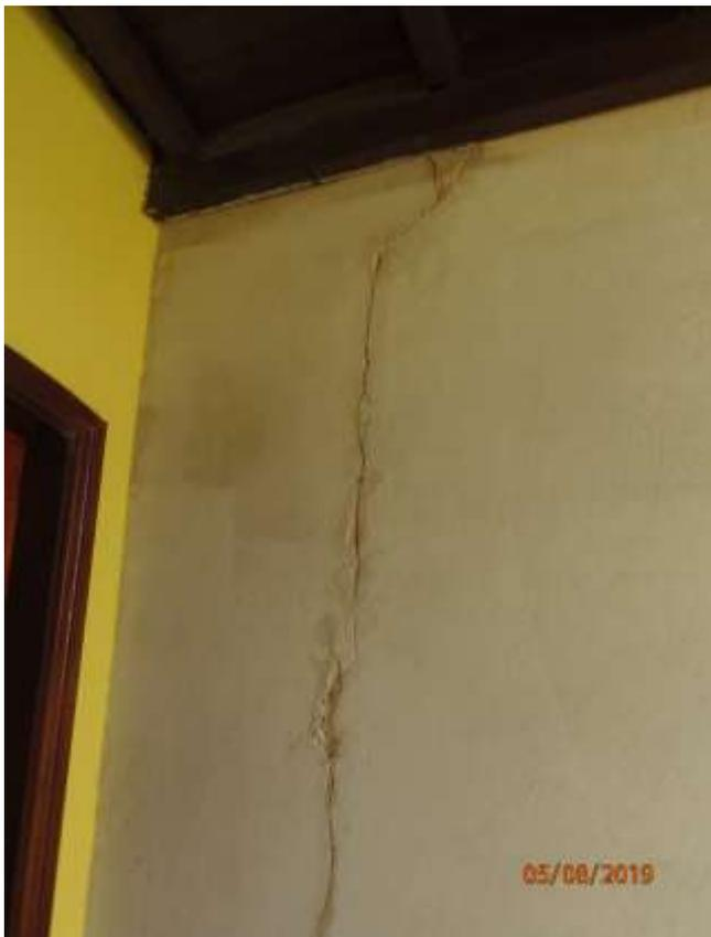
Foto 40 – Trinca e umidade na parede de divisa
