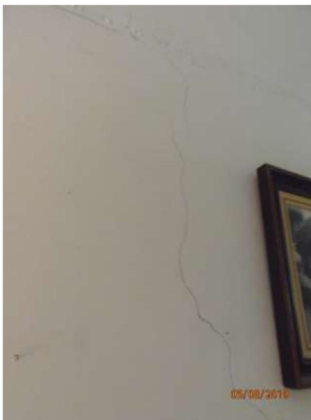
Foto 10 – Fissuras e trincas na parede
