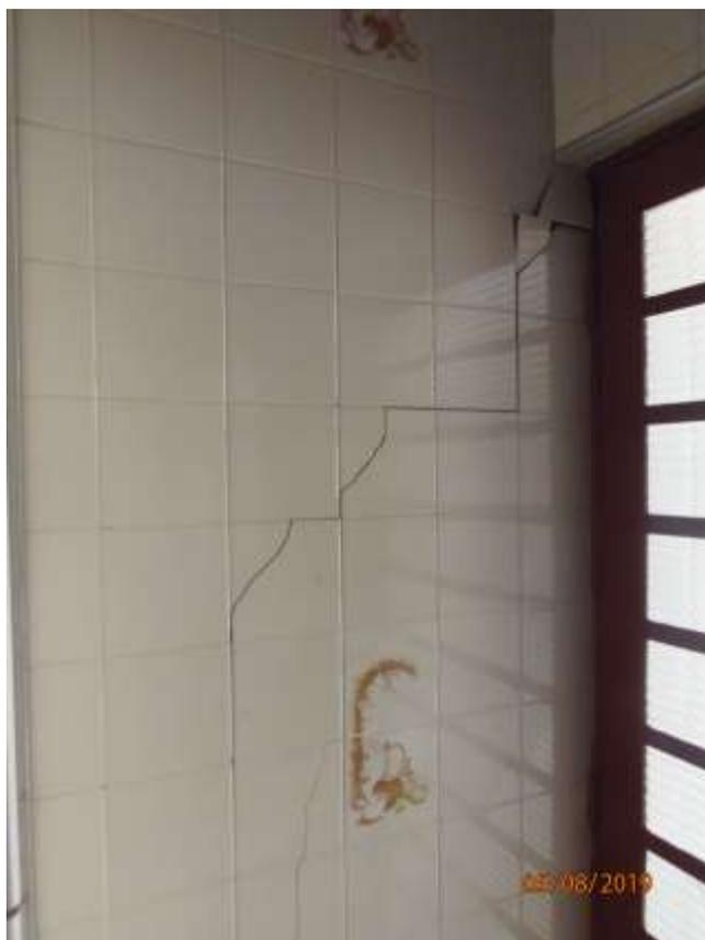
Foto 23 – Trinca na parede da cozinha
