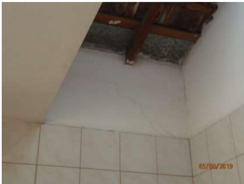
Foto 24 – Fissuras e trincas na parede da lavanderia
