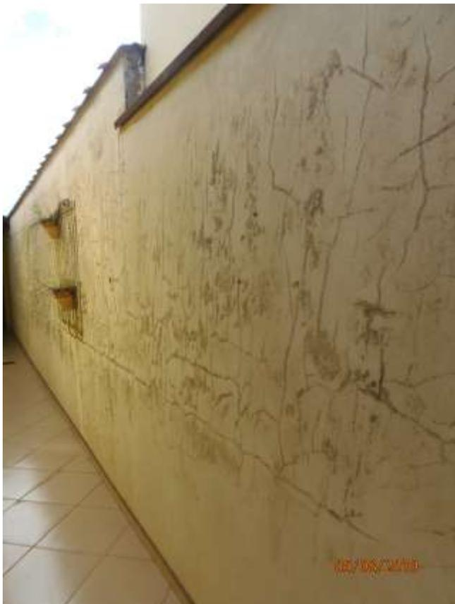
Foto 35 – Parede de divisa com umidade
