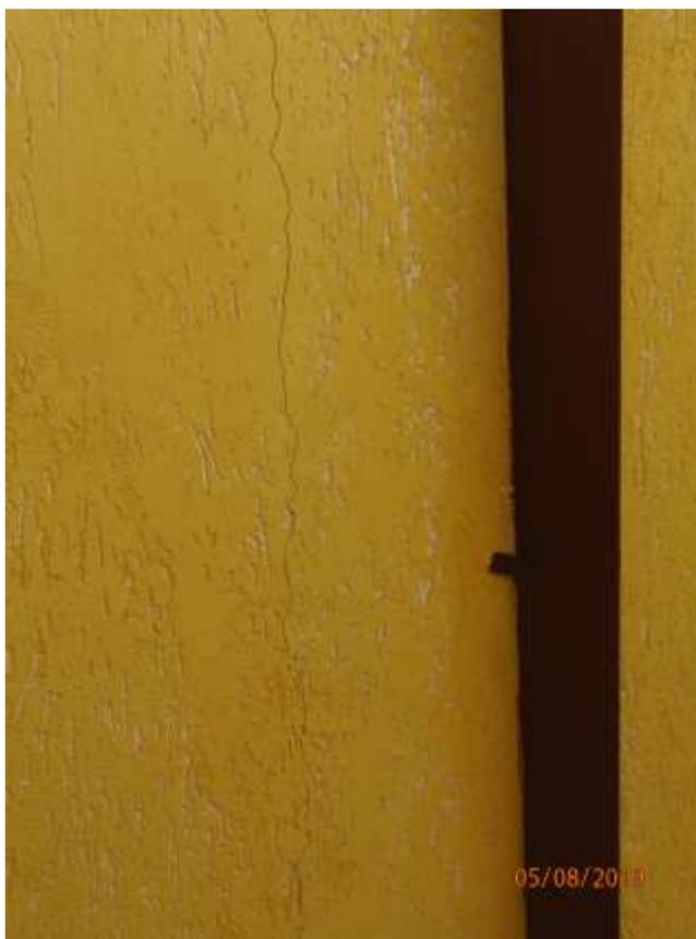
Foto 39 – Trinca na parede externa
