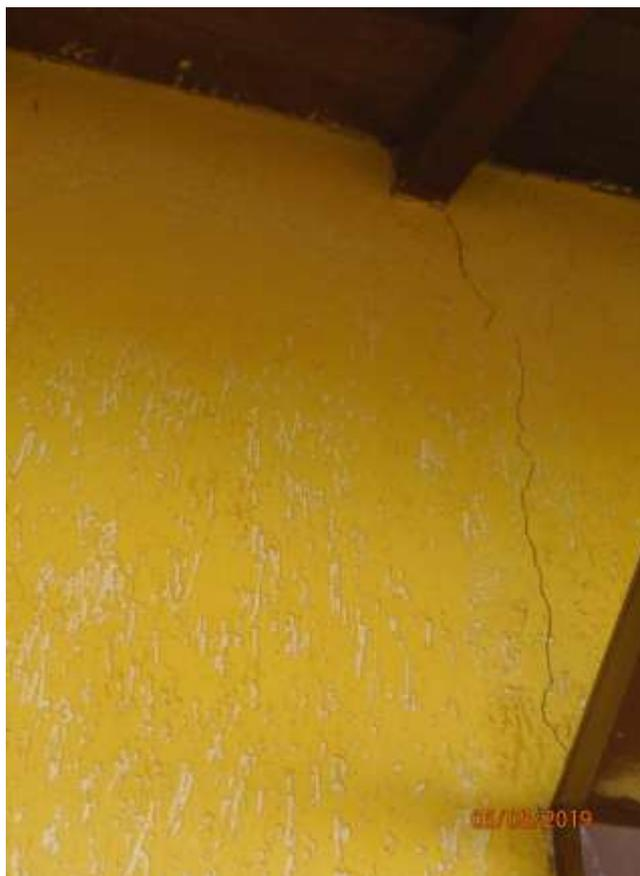
Foto 38 – Trinca na parede externa próxima ao abrigo
