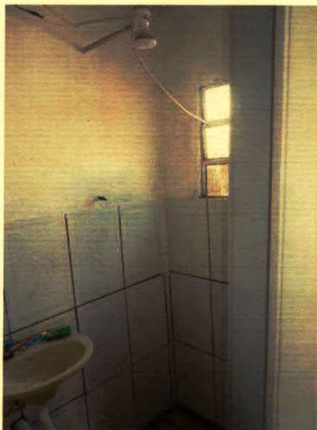
VISTA DO BANHEIRO.
