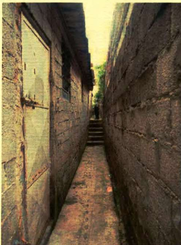
VISTA DO CORREDOR LATERAL.
