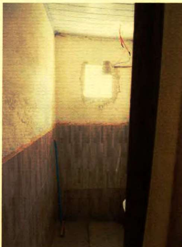
VISTA DO BANHEIRO.
