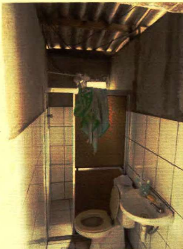
VISTA DO BANHEIRO.
