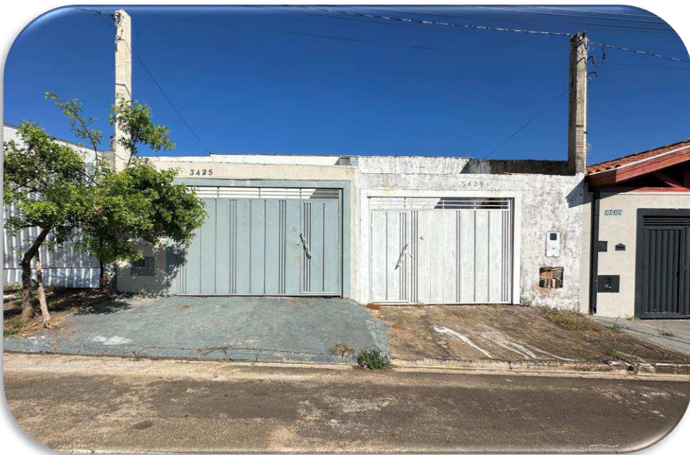
Vista do imóvel avaliando
