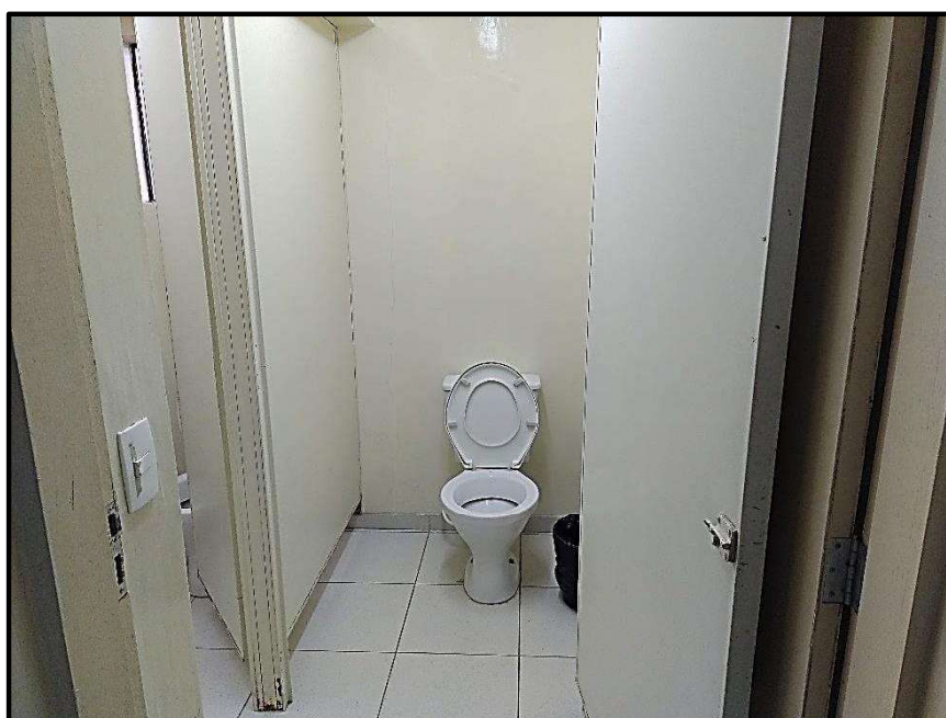
FOTO.05 – Aspecto do banheiro no pavimento térreo.
