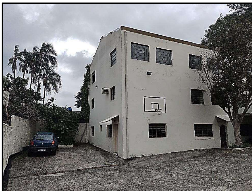
FOTO.03 – Aspecto do imóvel visto dos fundos do lote.
