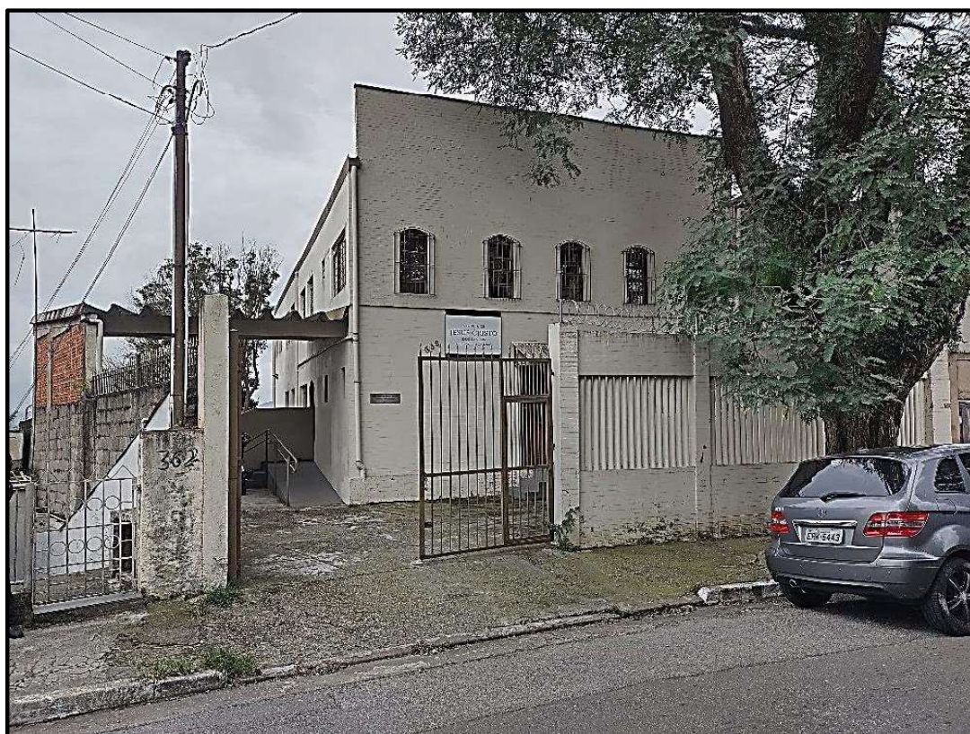
FOTO.01 – Aspecto do imóvel no trecho da rua considerada e junto da sua divisa da esquerda.
