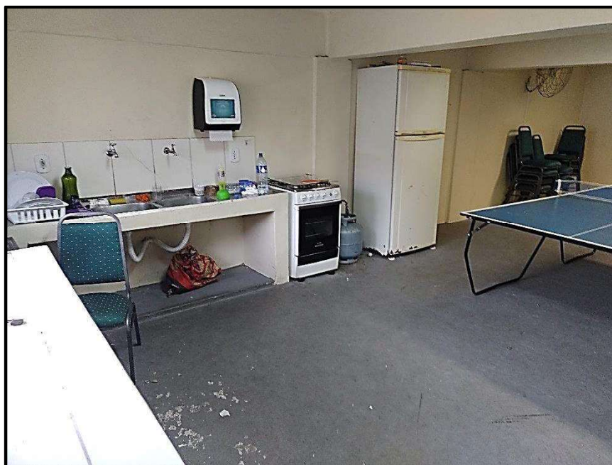
FOTO.13 – Aspecto interno da copa no pavimento inferior.
