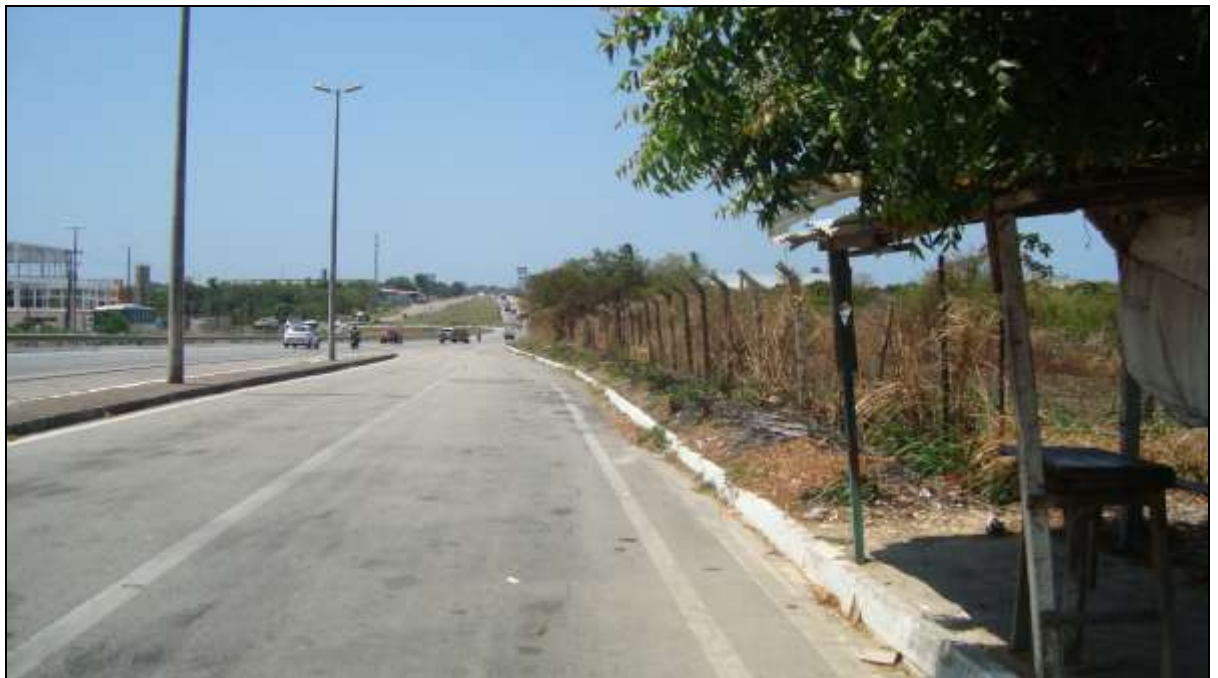
Foto 2 - Vista a direita o imóvel em avaliação com frente para a Rodovia BR 116, no município de Euzébio, onde ilustramos as divisas em alambrado do imóvel.
