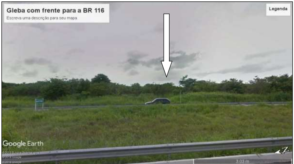
Foto 1 - Vista frontal do imóvel retratado na Escritura Pública de Cessão de Direitos Hereditários, com frente para a Rodovia BR 116, Km 17, lado esquerdo sentido Fortaleza – Itaitinga, onde ilustramos as características da via pública, em piso asfalto.
