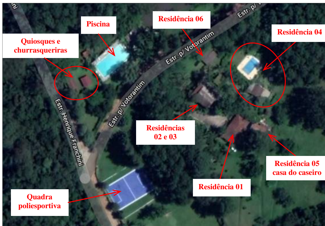
Figura 01: Foto aérea do imóvel avaliando. Destaque para as benfeitorias
