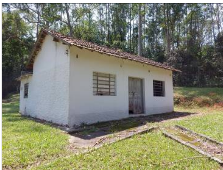
FOTOS 17/19 - Vistas da capeta e da escola do imóvel avaliando.
