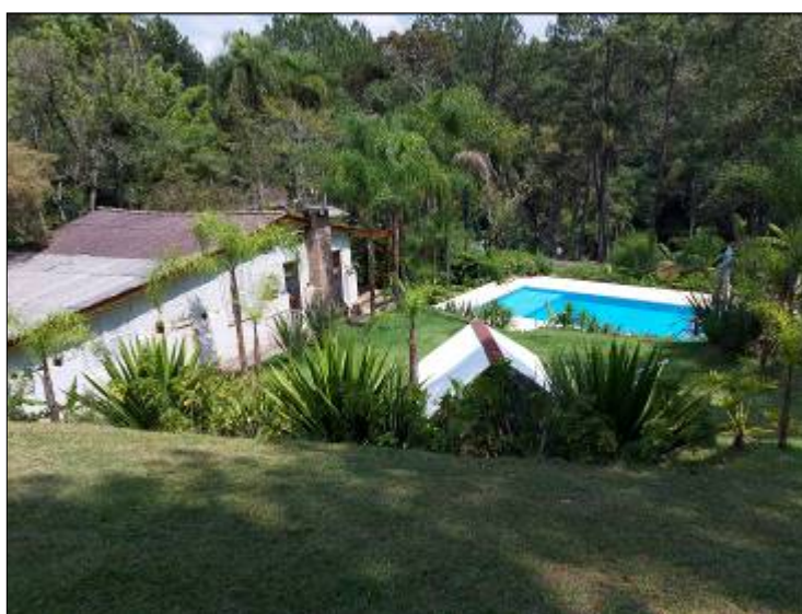
FOTOS 07/09 - Vistas de outra edificação existente no imóvel avaliando.
