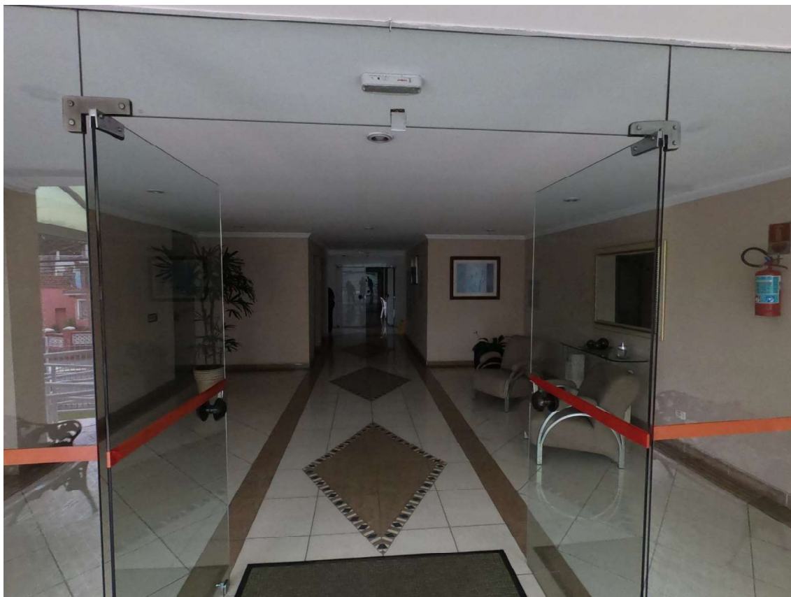
Foto 4. Entrada de acesso para os apartamentos e áreas comuns do condomínio.
