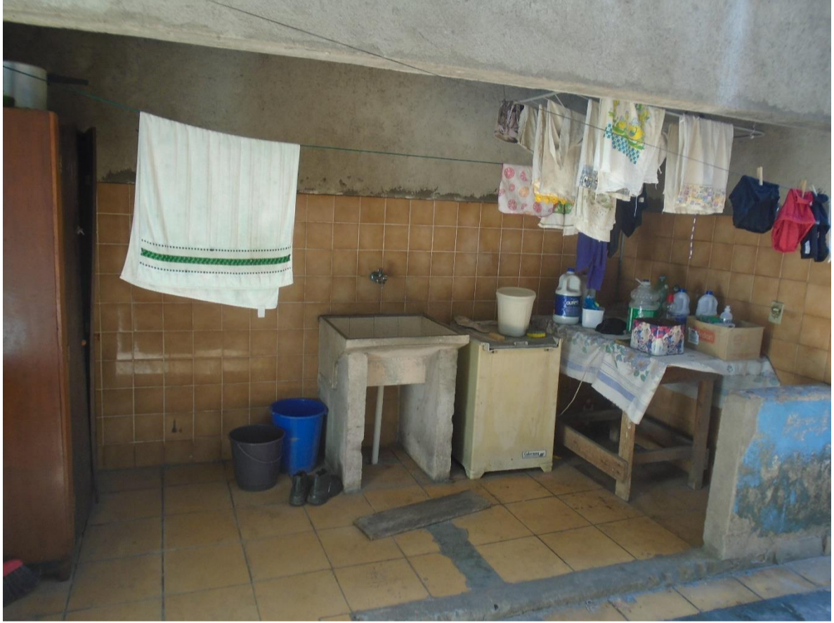
ÁREA DE SERVIÇO DA EDÍCULA TÉRREA.
