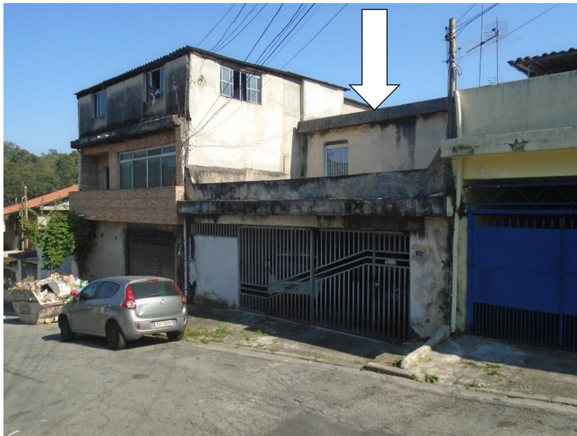
VISTA FRONTAL DO IMÓVEL.
