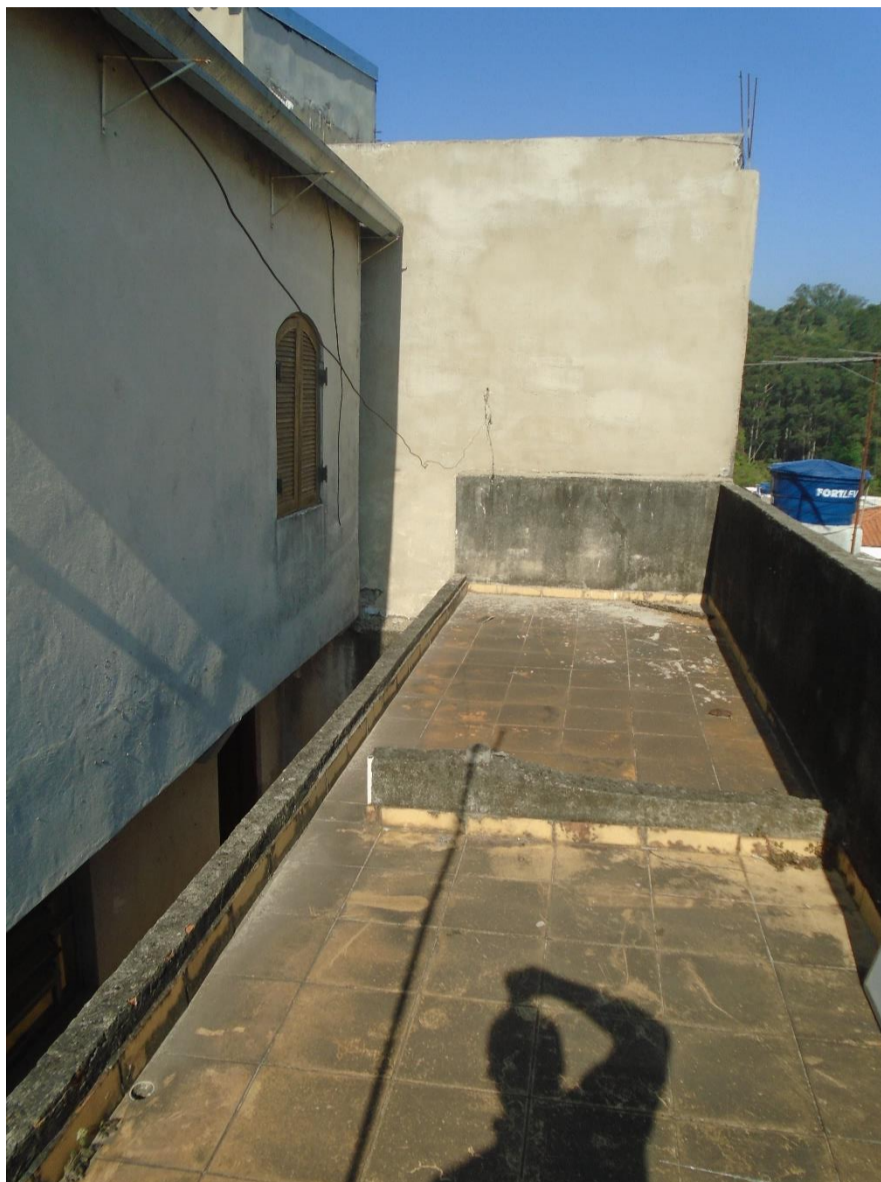
VISTA DA LAJE DE COBERTURA DA EDÍCULA.
