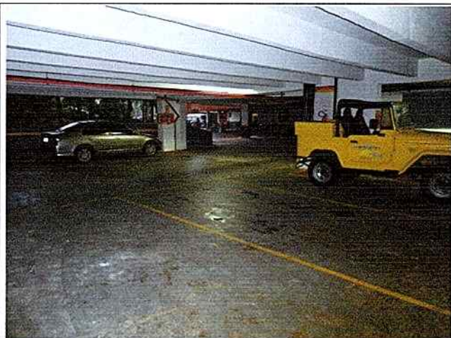
Foto 8: Vista geral do interior da garagem.
