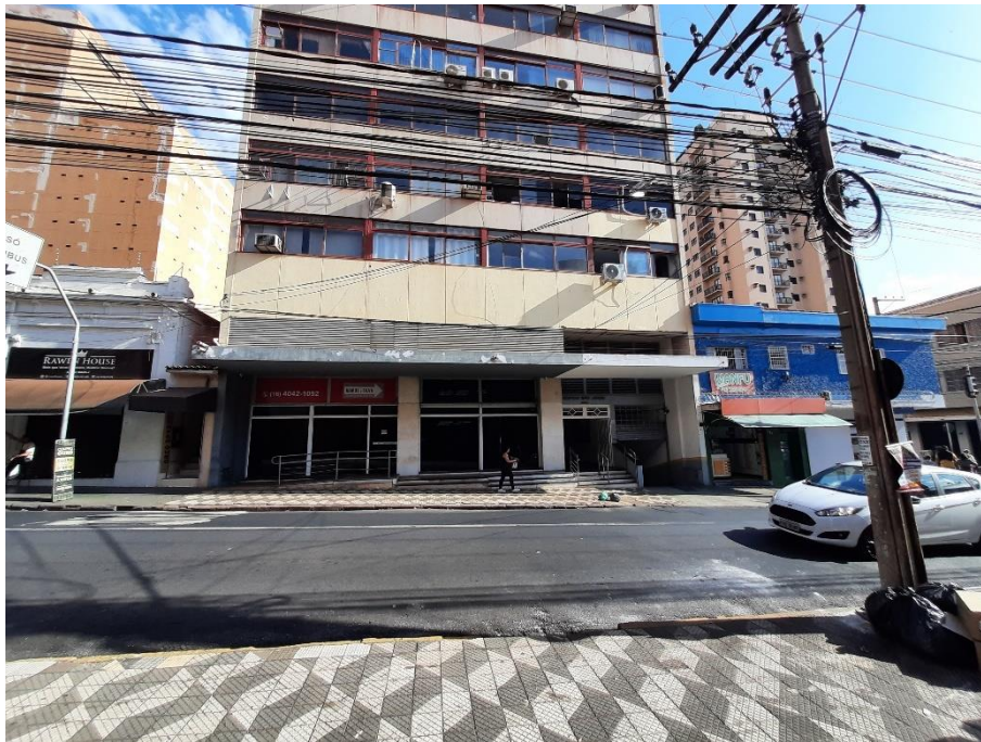
Foto 1 - Fachada do Edifício São Jorge
