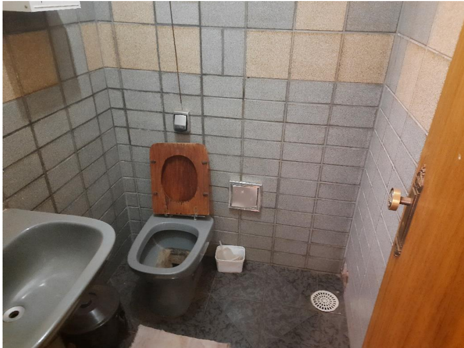
Foto 6 - Banheiro da Sala nº115
