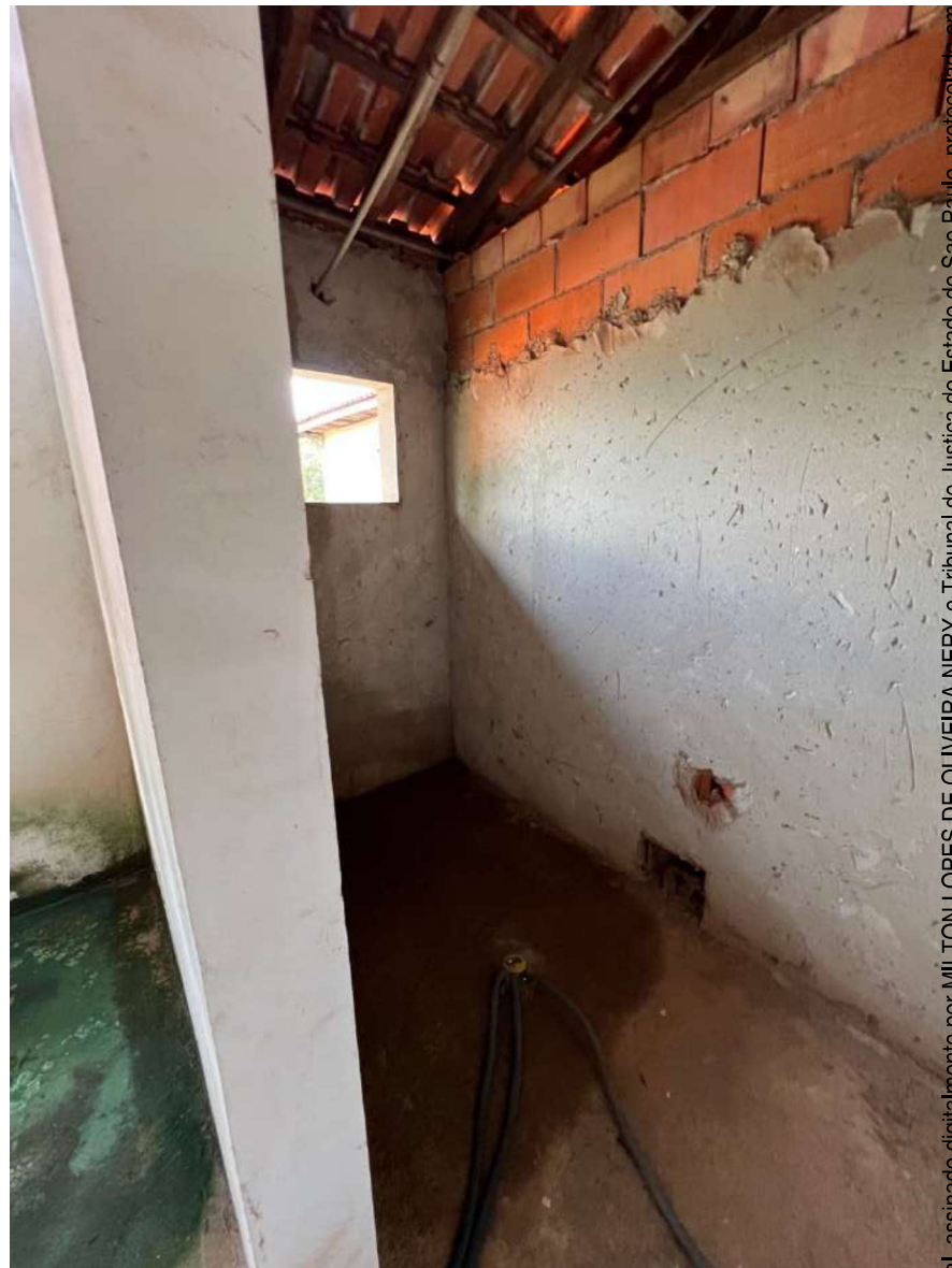
VISTA DO BANHEIRO DO 1º PAVIMENTO.
