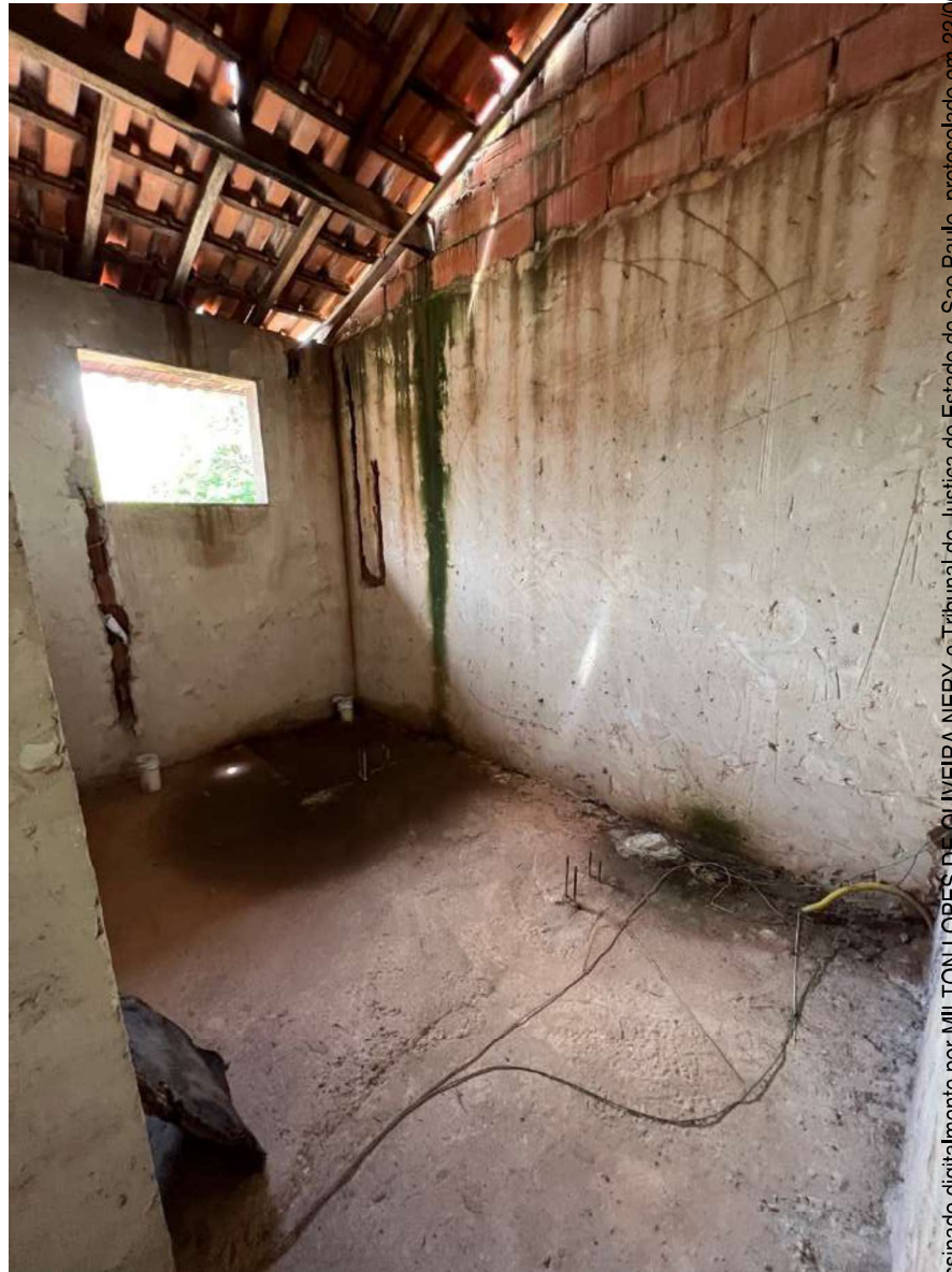
VISTA DO ROUPEIRO DO 1º PAVIMENTO, INACABADO.
