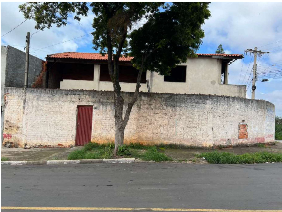
VISTA DA FACHADA DO IMÓVEL AVALIANDO.
