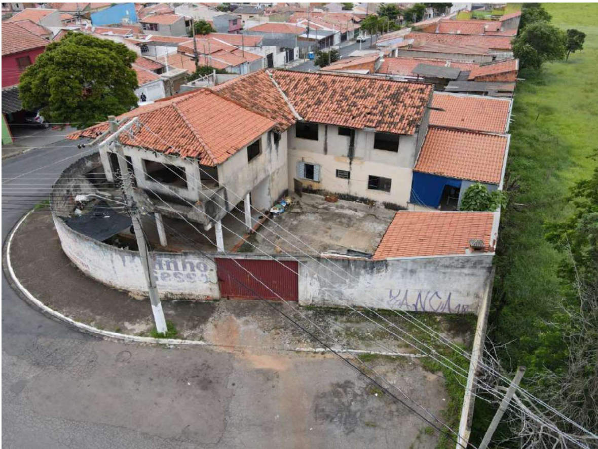
OUTRA VISTA DA LATERAL DIREITA DO IMÓVEL AVALIANDO (FOTO AÉREA TIRADA POR DRONE)
