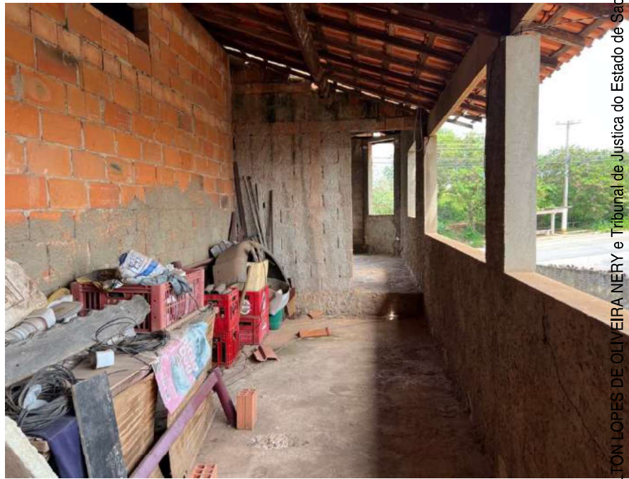
VISTA DA VARANDA DO 1º PAVIMENTO.
