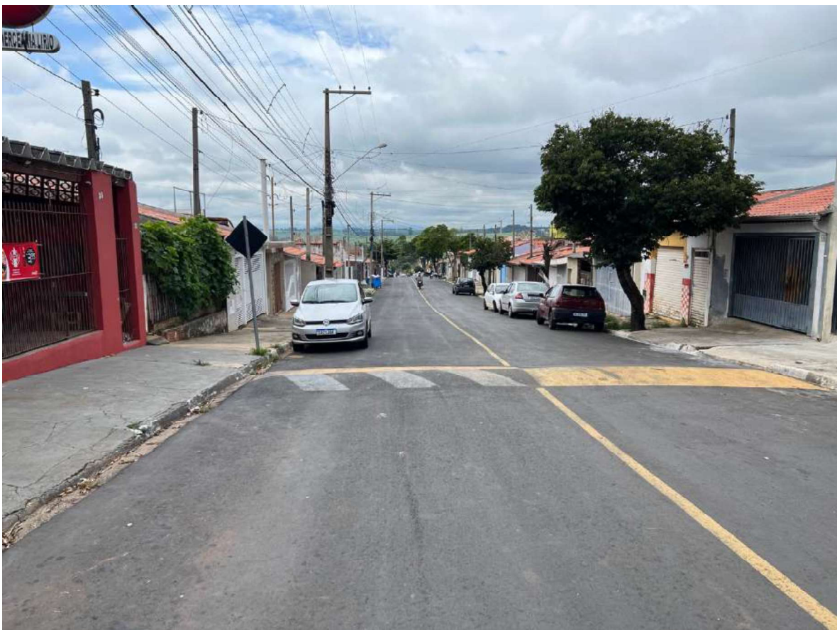
VISTA DA RUA ANTONIO EMILÍO DE OLIVEIRA, NO TRECHO ONDE SE SITUA O IMÓVEL AVALIANDO.
