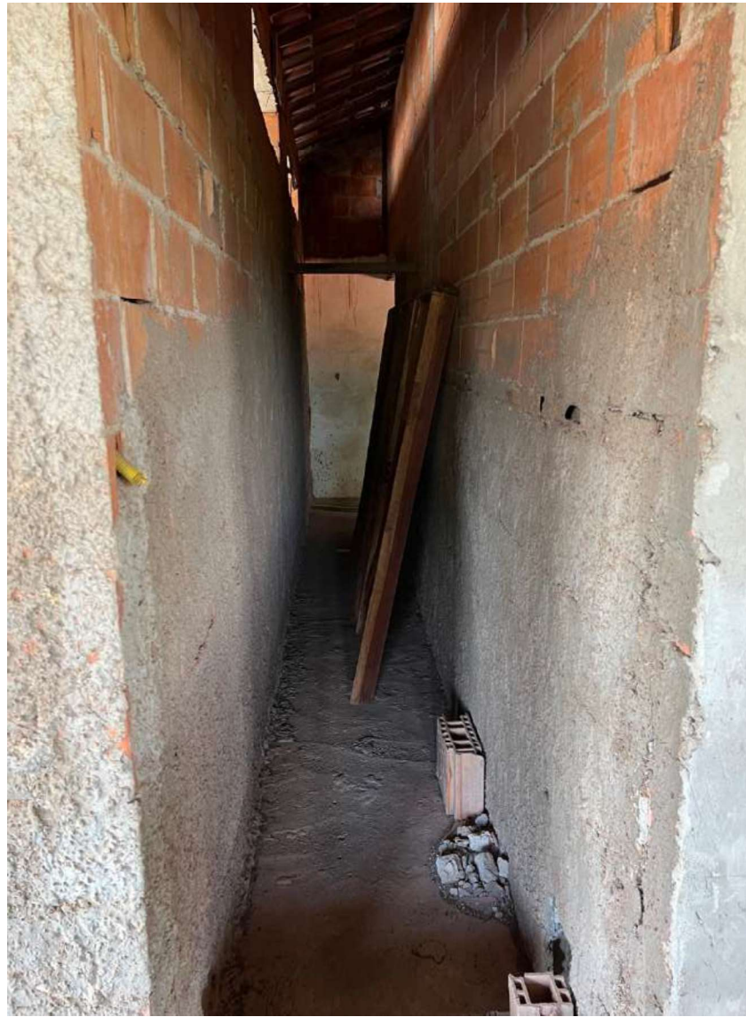
VISTA CORREDOR DO 1º PAVIMENTO, SEM ACABAMENTOS.
