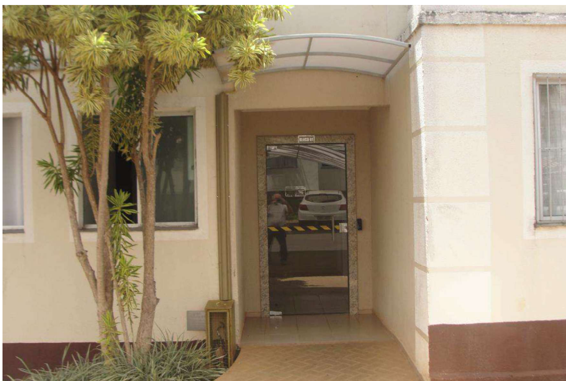
FOTO 01 – Visualiza a frente do imóvel avaliado para o interior do Condomínio Parque Franca Garden.
