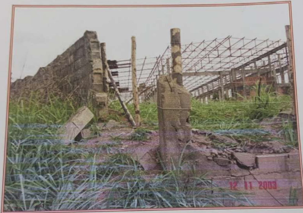
FOTO nº11: Vista parcial do imóvel a ser avaliado neste trabalho, onde podemos ver as os barracões e demais instalações da Empresa ora Requerente, nas margens da Rodovia Fausto Santomauro, a SP-127, no Km 11 + 200 metros. (Foto 12/11/03 - data da vistoria). Nesta fotografia podemos observa o que restou do barracão 1.
