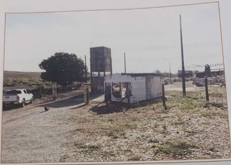
FOTO nº10: Vista parcial do imóvel a ser avaliado neste trabalho, onde podemos ver as os barracões e demais instalações da Empresa ora Requerente, nas margens da Rodovia Fausto Santomauro, a SP-127, no Km 11 + 200 metros. (Foto agosto de 2018 – data da vistoria). Nesta fotografia temos uma vista da portaria, como a fotografia anterior de 2003
