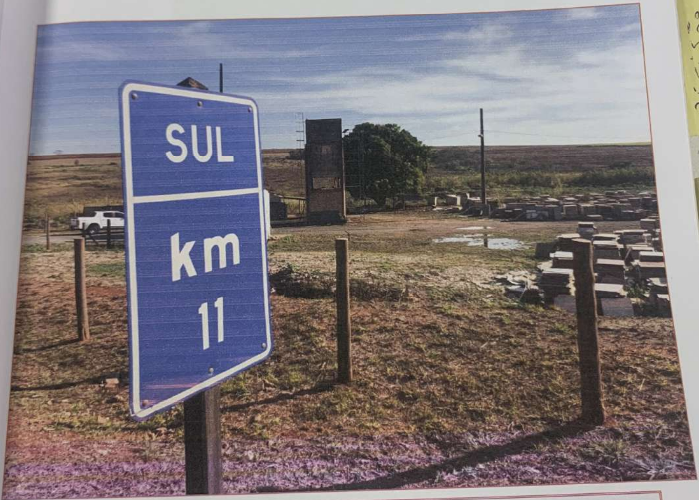
FOTO nº04: Vista parcial do imóvel a ser avaliado neste trabalho, onde podemos ver as barracões e demais instalações da Empresa ora Requerente, nas margens da Rodovia Fausto Santomauro, a SP-127, no Km 11 + 200 metros. (Foto agosto de 2018 – data da vistoria).
