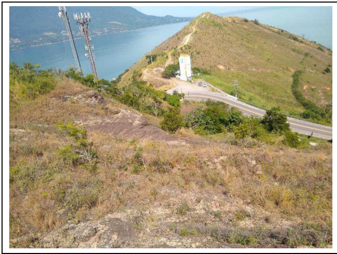
Foto 03 – Vista dos platôs de Rochas
