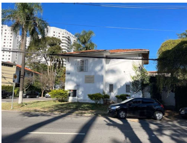
Fachada do imóvel pela Rua Verbo Divino
