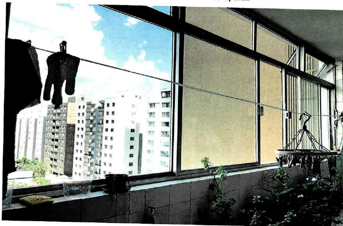
Foto 24: Esquadrias em Geral
