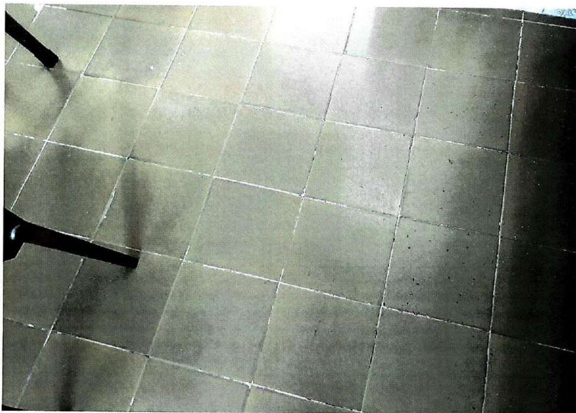
Foto 07: Piso Cerâmico Cozinha
