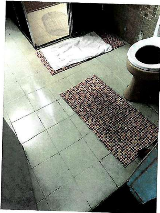
Foto 36: Piso Banheiro Social
