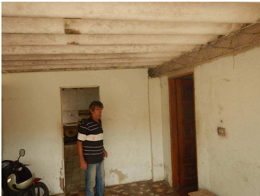
GARAGEM DA CASA 1.
