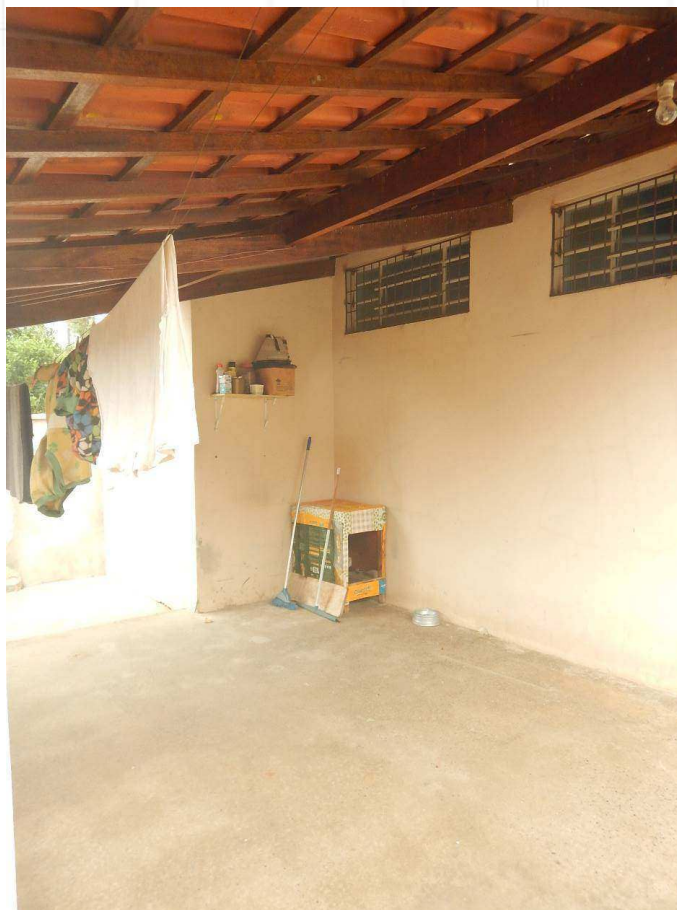
QUINTAL DA CASA 2, PODENDO-SE OBSERVAR OS FUNDOS DO SALÃO COMERCIAL.
