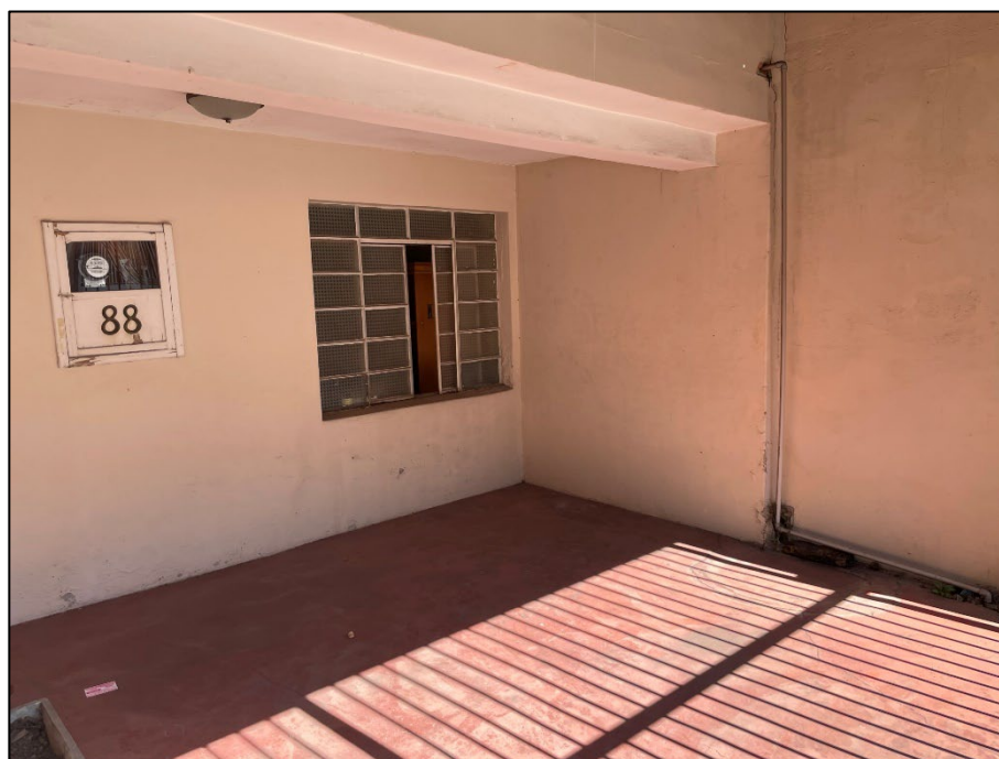
Foto 4 – Rua Riachuelo, n.º 88 – Garagem
