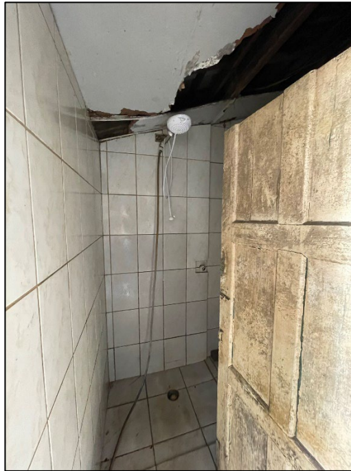
Foto 11 – Rua Riachuelo, n.º 88 – Banheiro – Vista 1
