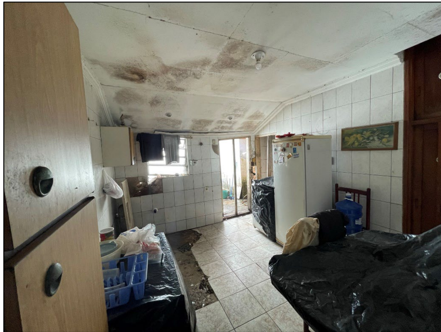
Foto 9 – Rua Riachuelo, n.º 88 – Cozinha – Vista 1
