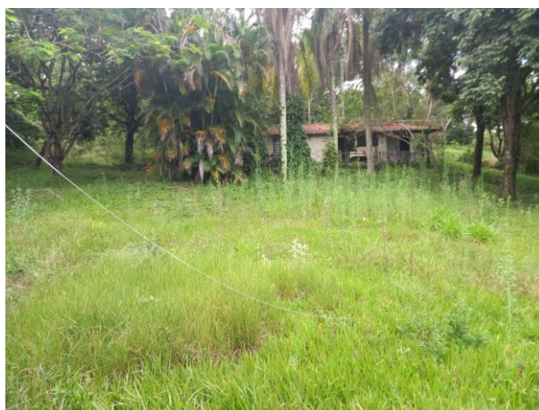
- Casa caseiro feita em alvenaria de tijolos de barro; cobertura com telhas de barro tipo francesa; esquadrias metálicas; estado de conservação regular.
