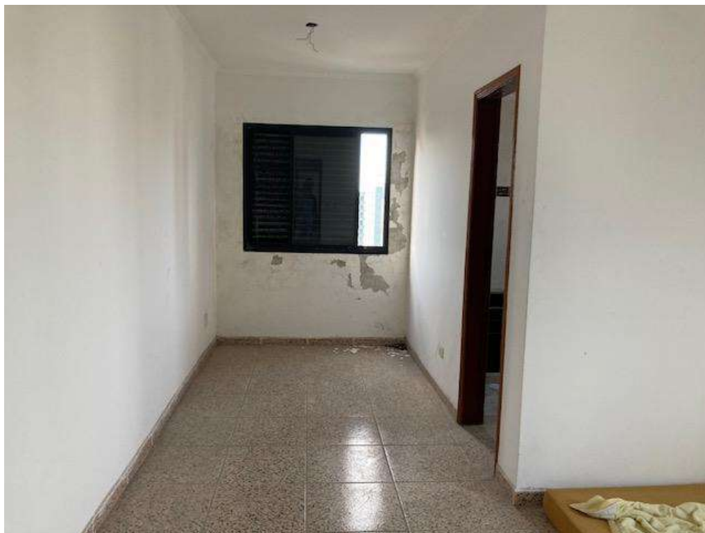
Foto 17 | Suíte com piso em cerâmica, paredes com tinta látex PVA apresentando desagregação na argamassa junto da janela de correr, com veneziana em alumínio e forro de gesso.
