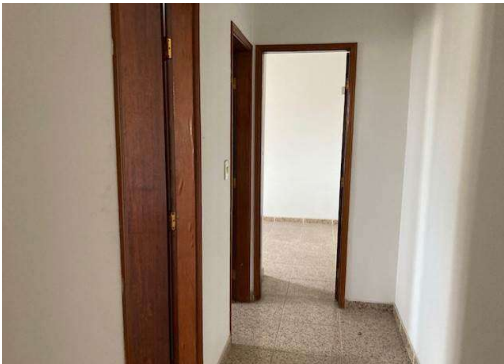
Foto 13 | Corredor de acesso aos dormitórios e sanitários. Piso em cerâmica, paredes com tinta látex PVA, portas de madeira lisa, com verniz. Foto: Gino Caldatto | jul.2022.
