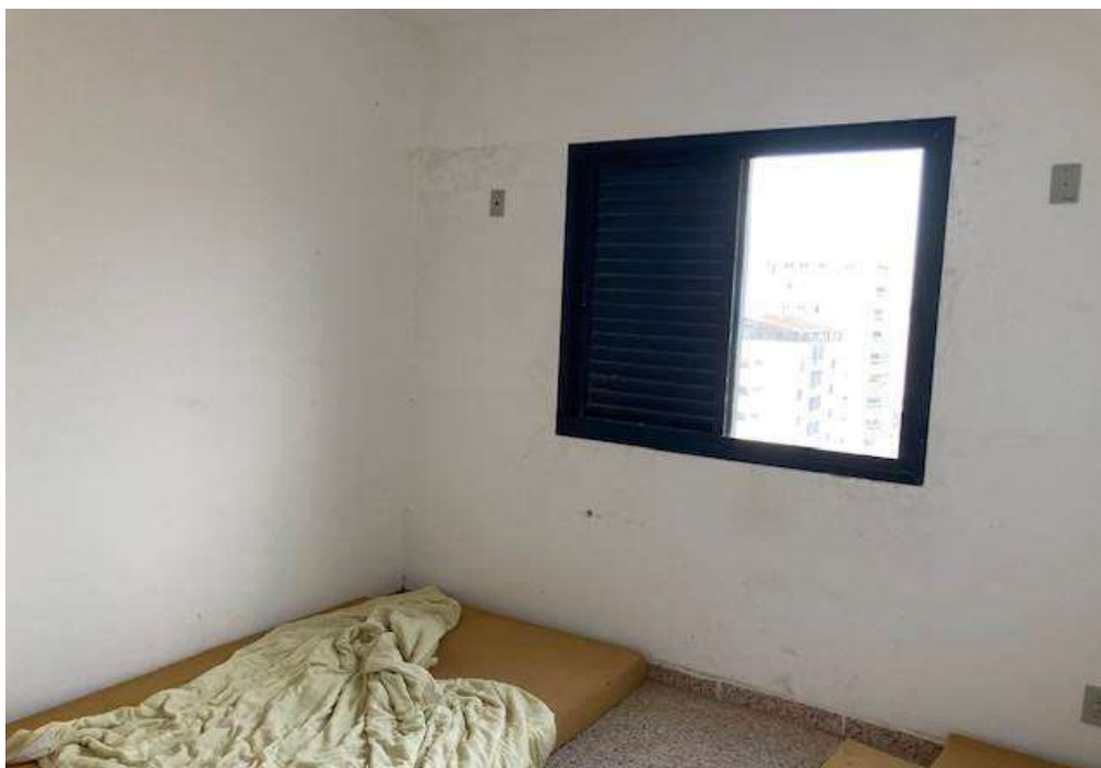
Foto 16 | Suíte com piso em cerâmica, paredes com tinta látex PVA apresentando desagregação na argamassa, janela de correr com veneziana em alumínio e forro de gesso.
