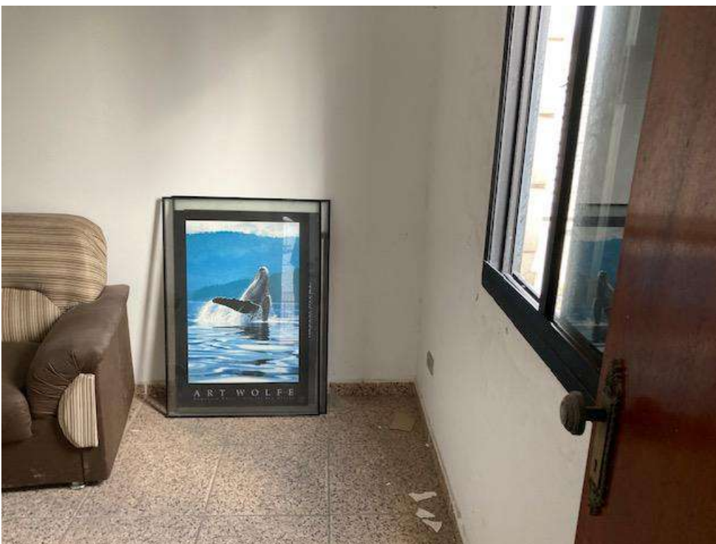
Foto 17 | Dormitório de empregada com piso em cerâmica, paredes com tinta látex PVA, janela de correr com veneziana em alumínio. Foto: Gino Caldatto | jul.2022.
