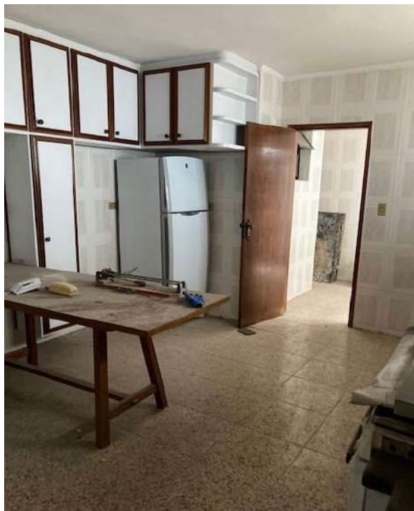
Foto 20 | Cozinha com acabamentos de piso em cerâmica, e revestimento das paredes igualmente em cerâmica na altura do pé-direito, porta em madeira com ligação para área de serviço. Foto: Gino Caldatto | jul.2022.
