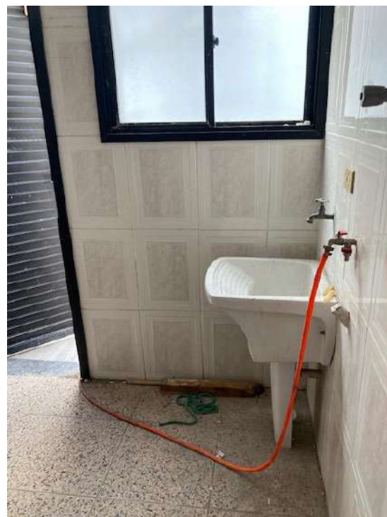
Foto 21 | Área de serviço com acabamentos de piso em cerâmica, e revestimento das paredes igualmente em cerâmica na altura do pé-direito, e janela de correr em alumínio. Foto: Gino Caldatto | jul.2022.
