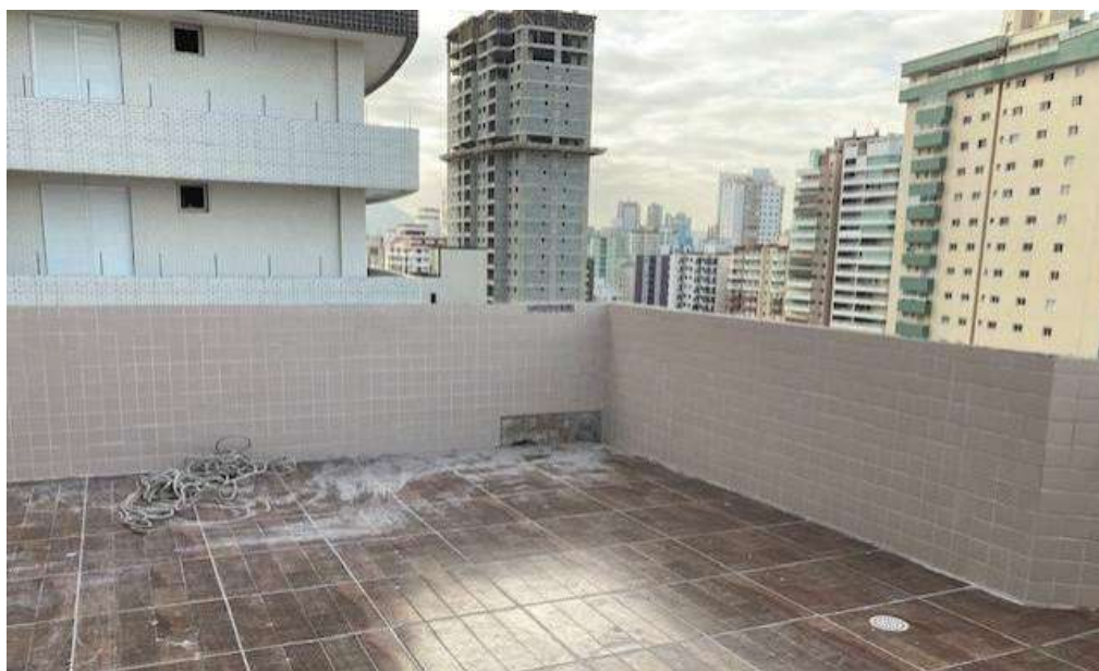
Foto 12 | Terraço em frente a sala de jantar, com novo revestimento cerâmico.
