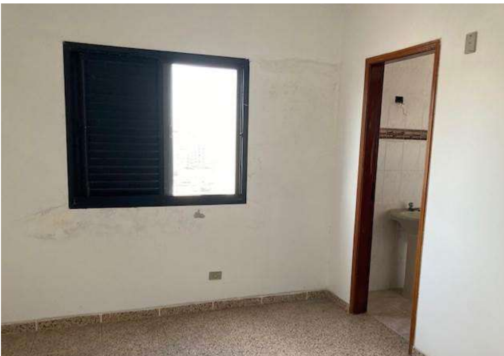
Foto 14 | Suíte com piso em cerâmica, paredes com tinta látex PVA, janela de correr com veneziana em alumínio, porta de madeira lisa, com verniz. Foto: Gino Caldatto | jul.2022.
