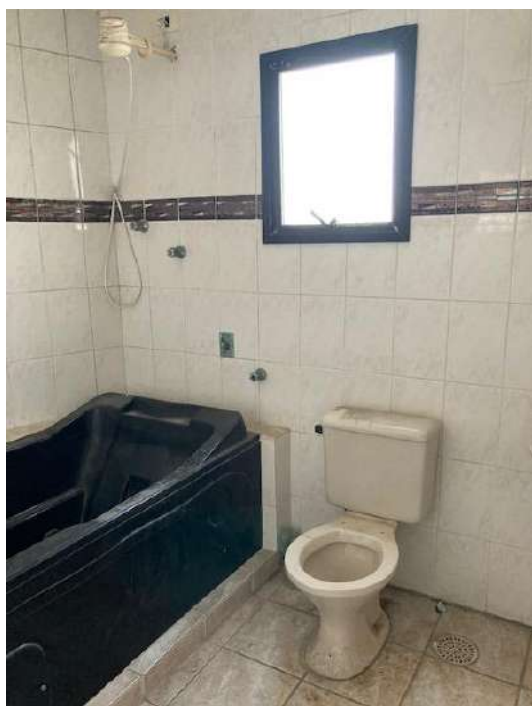
Foto 17 | Suíte com piso em cerâmica, paredes com tinta látex PVA apresentando desagregação na argamassa junto da janela de correr, com veneziana em alumínio e forro de gesso.
