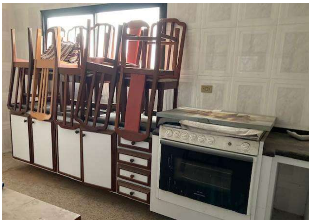
Foto 19 | Cozinha com acabamentos de piso em cerâmica, e revestimento das paredes igualmente em cerâmica na altura do pé-direito, e janela de correr em alumínio. Foto: Gino Caldatto | jul.2022.
