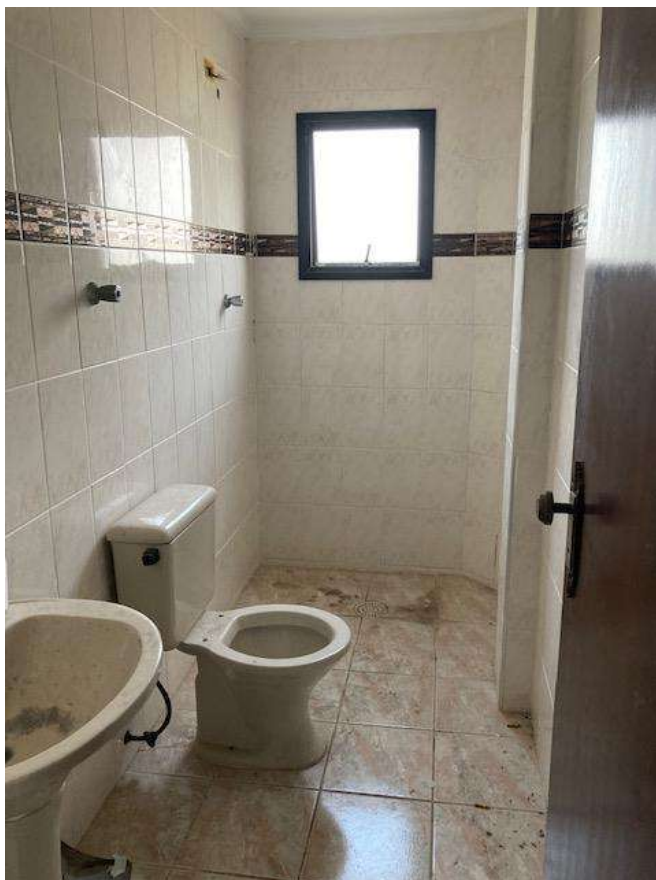
Foto 18 | Banheiro da empregada revelando os acabamentos do piso de cerâmica, e revestimento das paredes igualmente em cerâmica na altura do pé-direito, e janela de alumínio maxim-air . Foto: Gino Caldatto | jul.2022.
