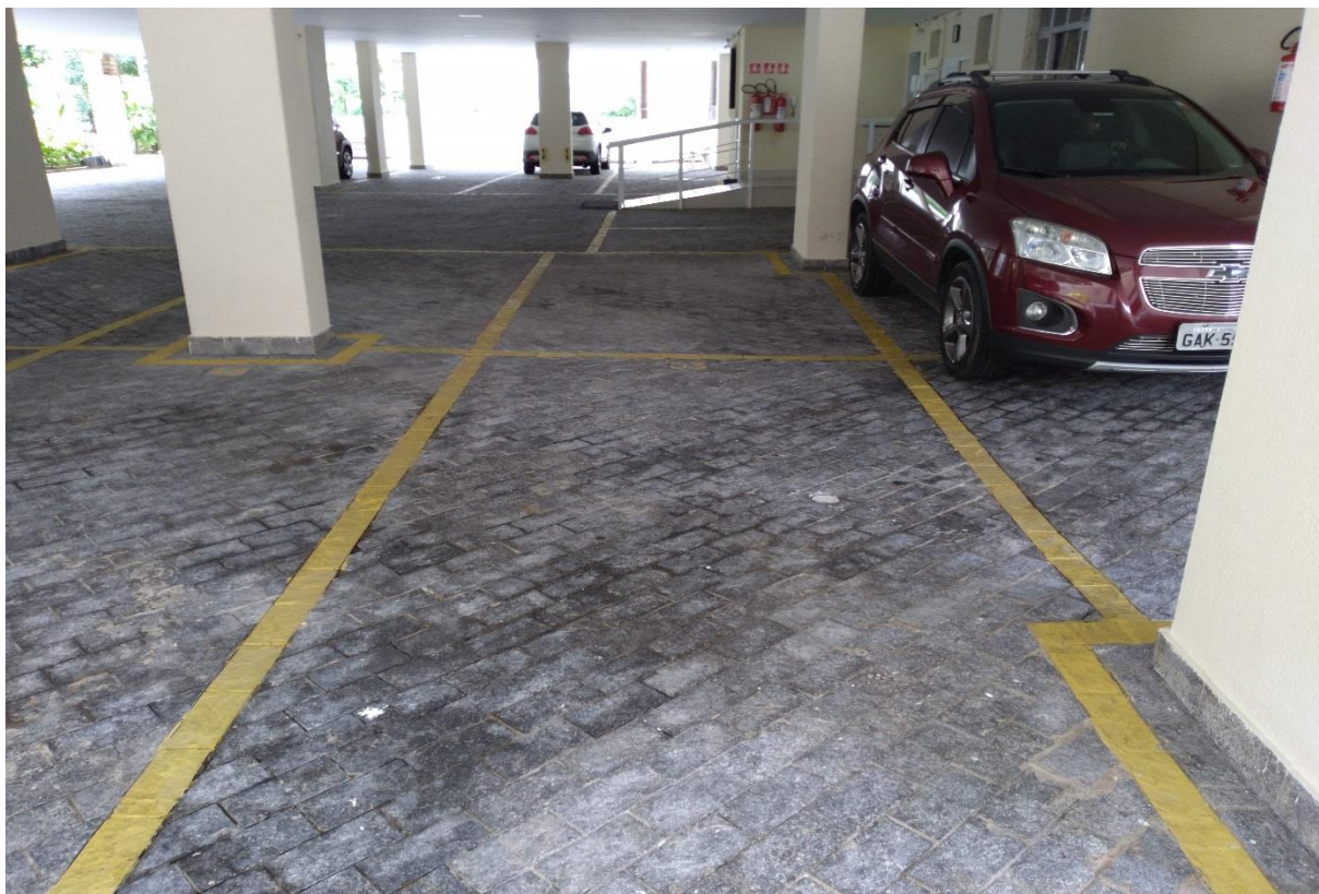
FOTO 27 – Vista parcial da área para estacionamento de 2(dois) veículos da unidade nº 53, situada no pavimento térreo.
