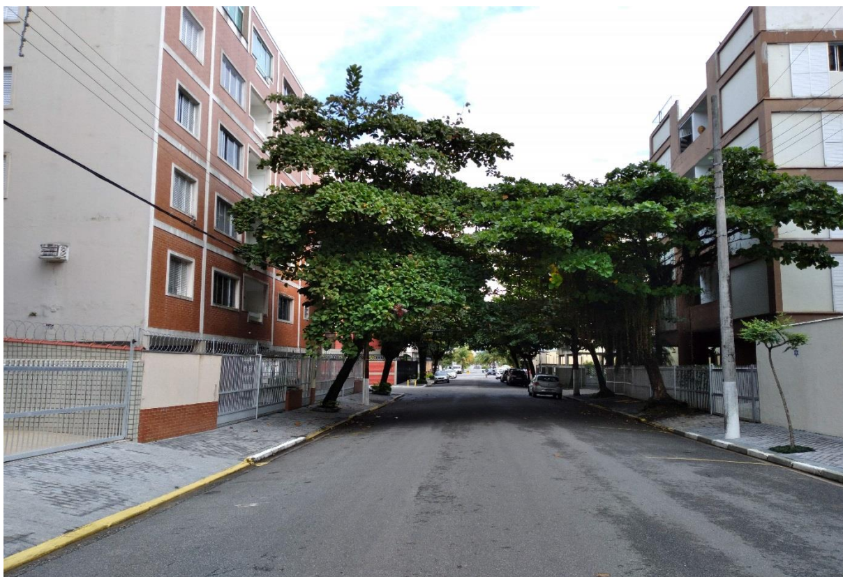
FOTO 02 - Vista parcial da Rua Abdala Daige, onde se situa a fachada frontal principal.
