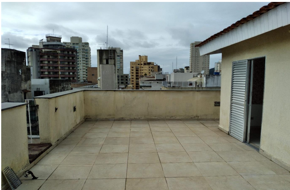
FOTO 26 – Vista parcial do terraço descoberto e suíte, em área não averbada na matrícula do imóvel.
