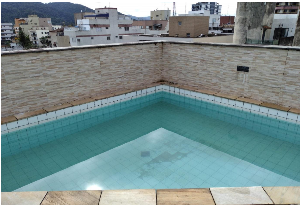
FOTO 23 – Vista parcial da piscina no terraço descoberto do imóvel avaliando.
