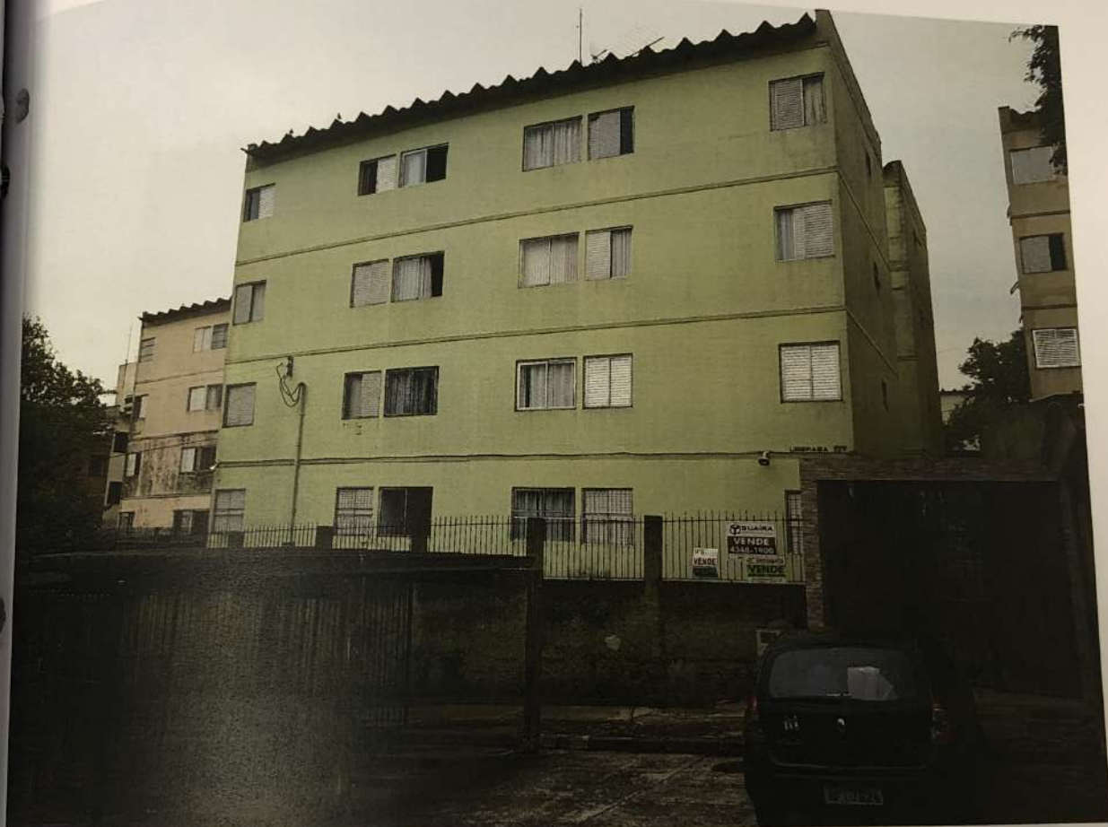
FOTO 4: VISTA GERAL DO EDIFÍCIO ONDE ESTÁ INSERIDA A UNIDADE AVALIANDA EM QUESTÃO.
