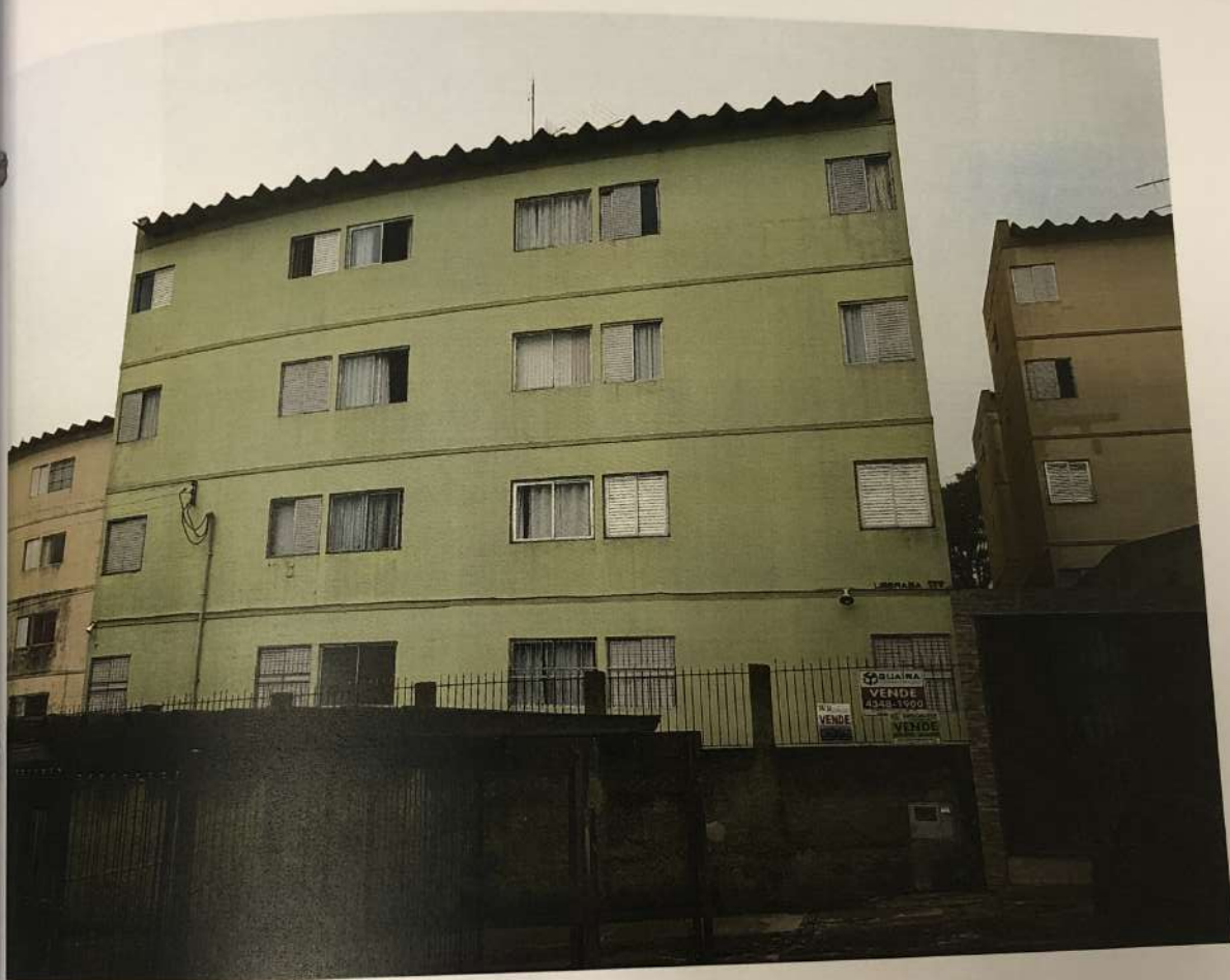
FOTO 5: VISTA GERAL DO EDIFÍCIO ONDE ESTÁ INSERIDA A UNIDADE AVALIANDA EM QUESTÃO.
