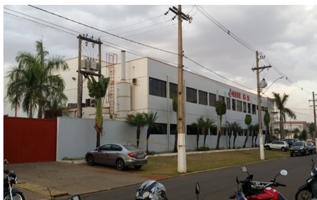
Vista Lateral – Rua 6
