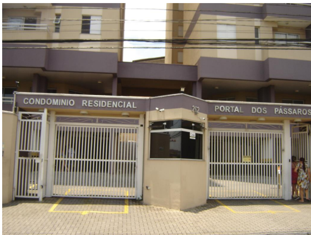
Vista da entrada social e garagem do condomínio
